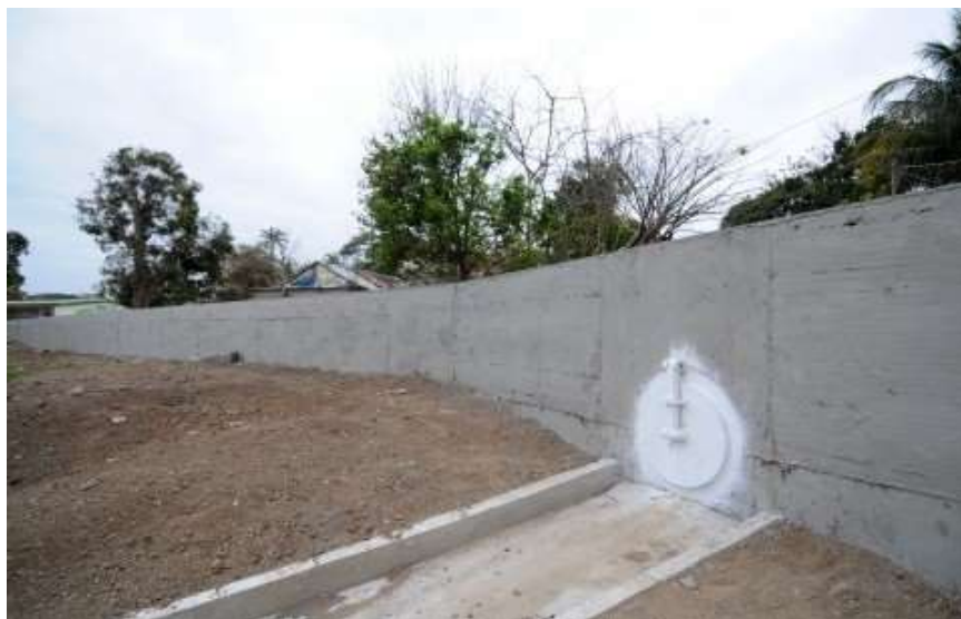
Figura 4-1 Compuertas muro perimetral
