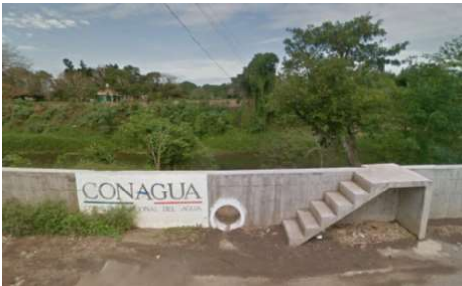
Figura 3-26 Muro perimetral zona urbana Medellín
