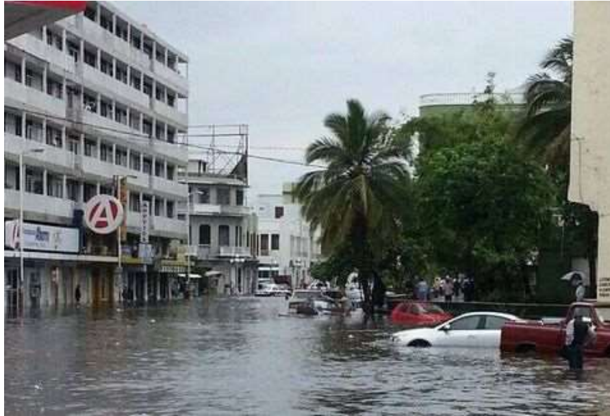
Figura 3-24 Lluvias generadas por la depresión tropical 90-L dejaron afectaciones en viviendas, milenio.com/estados/Veracruz-lluvias-inundaciones-depresion_tropical-danos_por_lluvias_0_313168832.html
