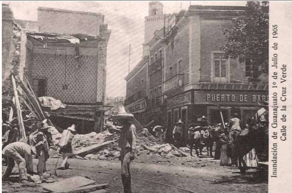
Figura 3-24. Efectos causados por la inundación de julio de 1905.
