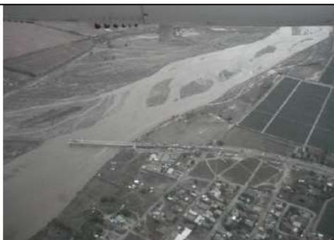
Foto 25- Puente Santo Domingo.- Con falla evidente por la crecida del arroyo Colonia Vicente Guerrero.
