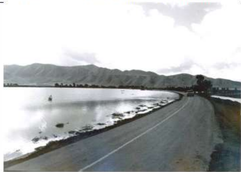
Foto 14- Camino a la Bufadora, vista al sur
