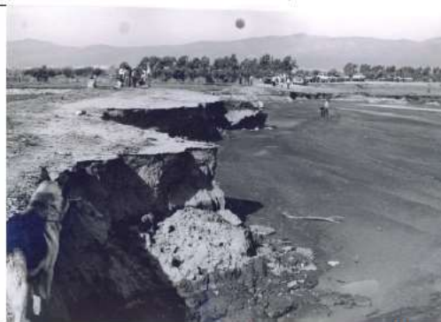
Foto 15- Carretera a la Bufadora, vista al norte que muestra la socavación.
