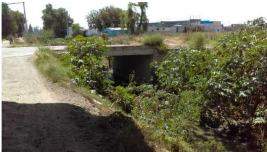
Figura 4-7 Canal (Río Xalapango) en la zona urbana de San Salvador Atenco, Estado de México.
