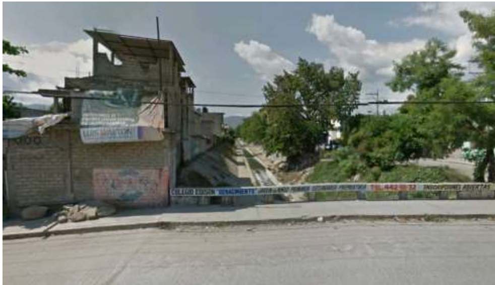
Figura 4-4 Ocupación de zona federal en margen derecha del cauce que descarga al río Sabana, calle Interior colonia Renacimiento
