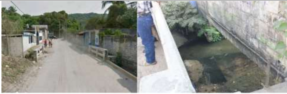
Figura 4-3 Construcciones sobre cauce que descarga al río Sabana, calle Regina colonia La Garrapata
