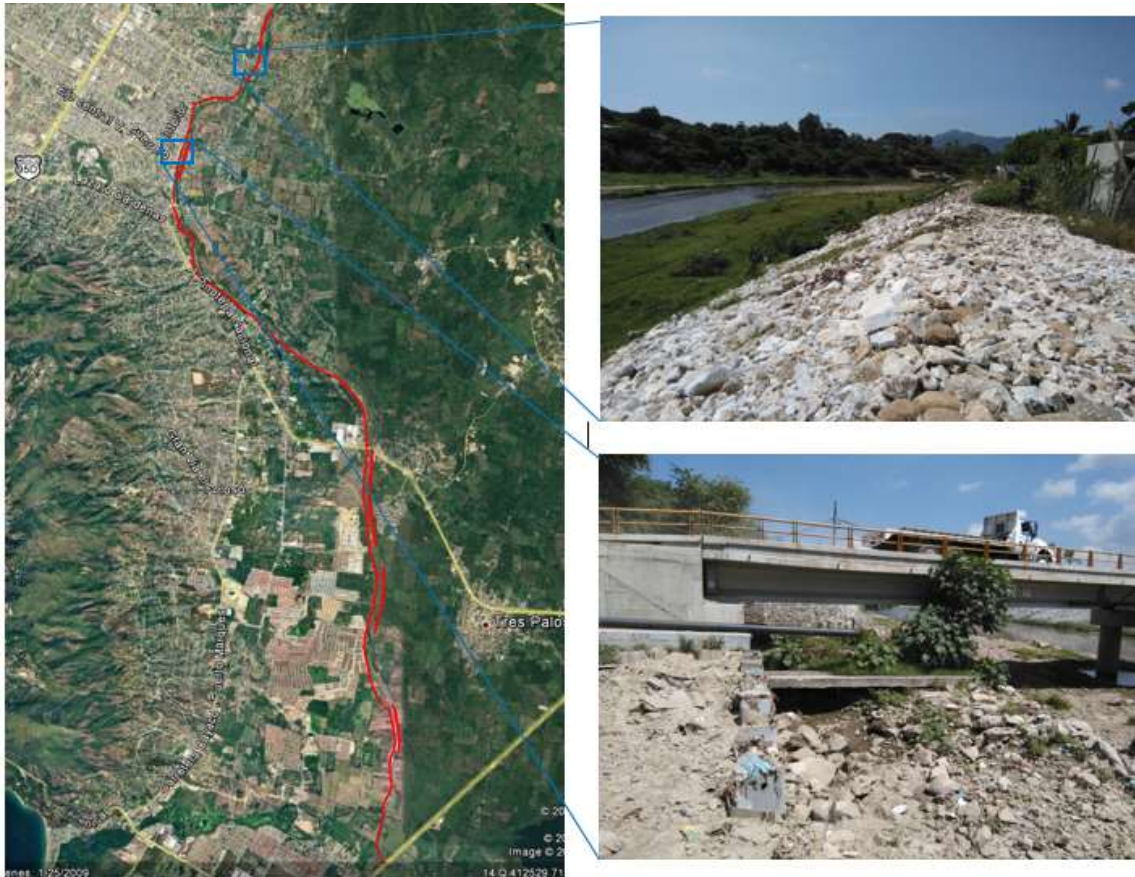
Figura 3-27 Protección marginal actual del río Sabana
