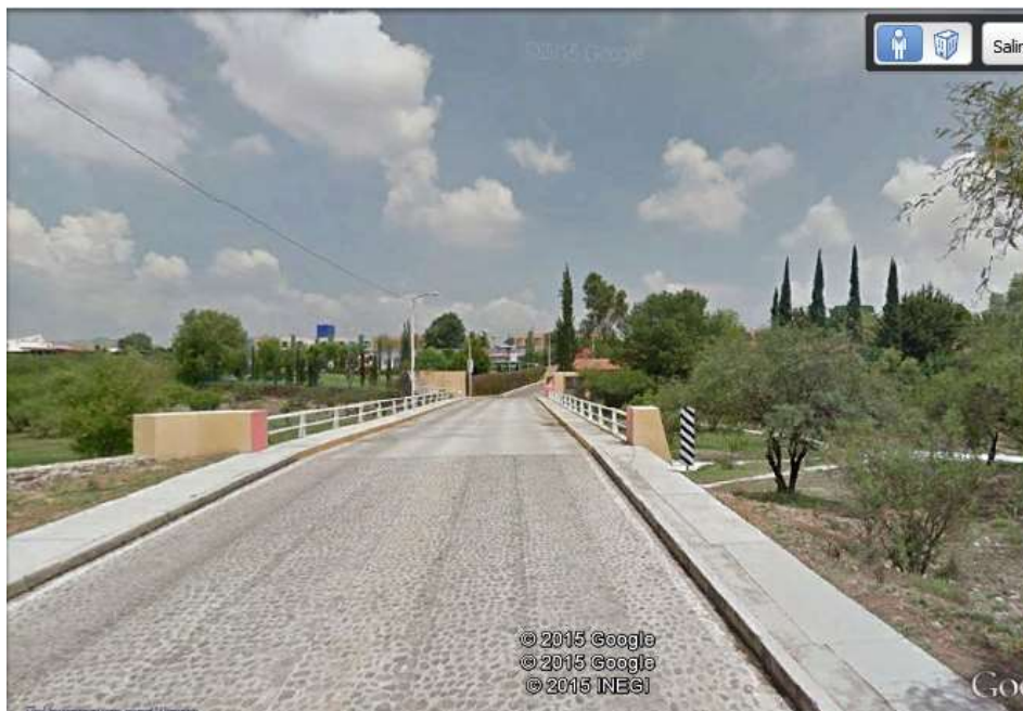
Figura 5.12 Cruce Río San Juan del Río y la avenida Francisco Martínez Elías
