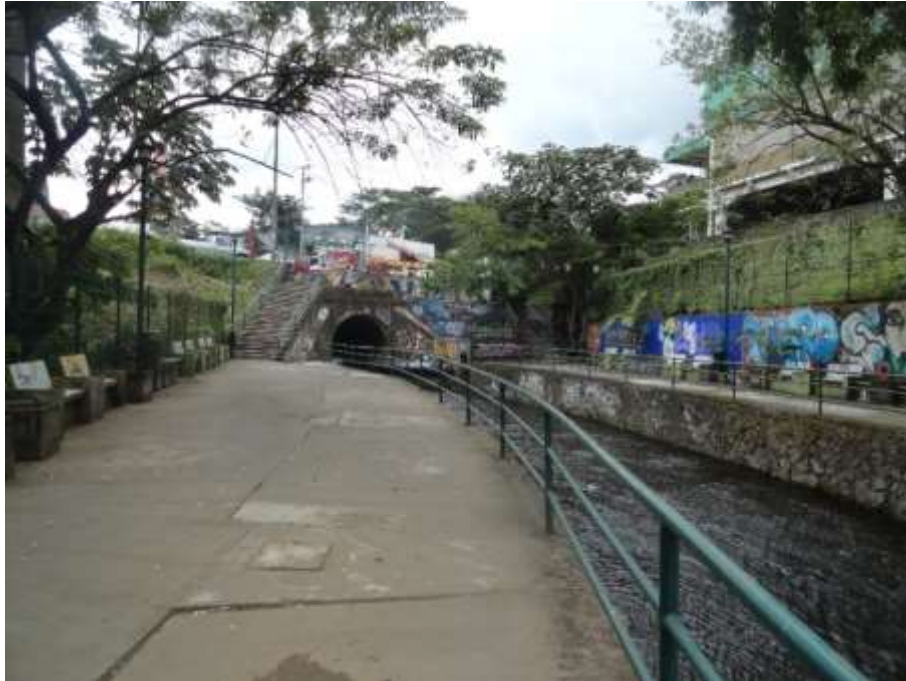
Figura 5-32. Alcantarilla de sección de herradura en Carretera Veracruz-Coatzacoalcos
