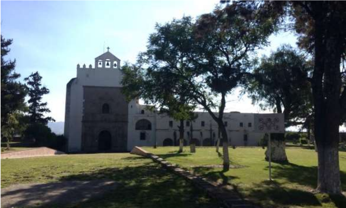
Figura 5.28 Ex-Convento de Acolman ubicado en una zona baja
