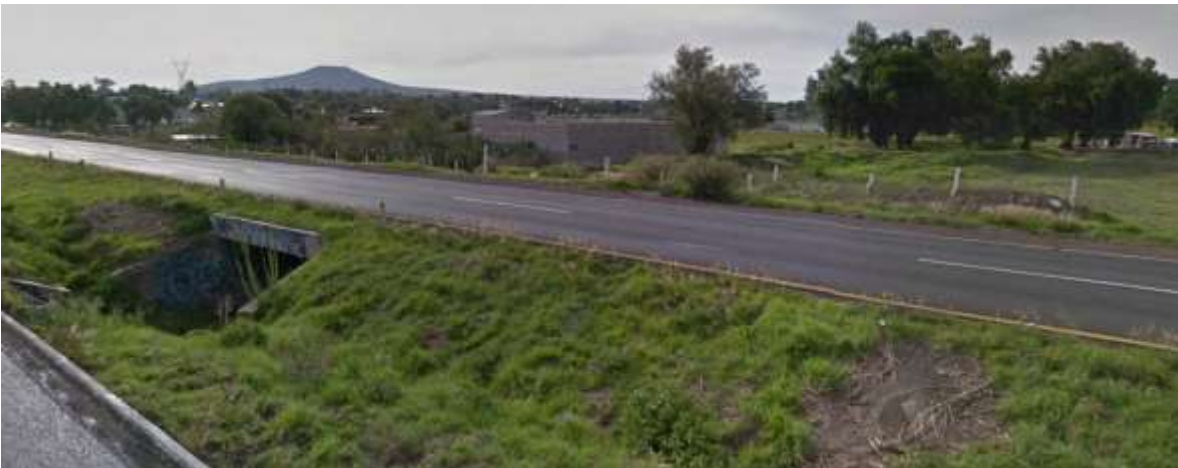
Figura 5.24 Alcantarillas sobre el Río Chico cruce con la carretera México-Pirámides
