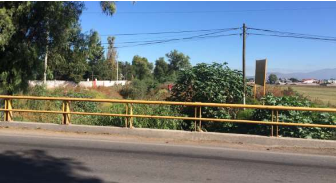
Figura 5.29 Vista del cauce del Río Grande o San Juan a la altura del puente Acolman
