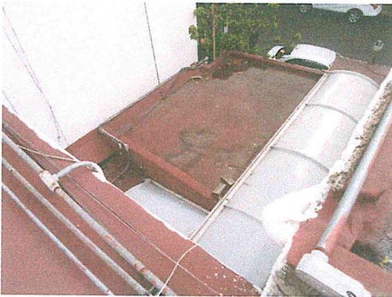
Foto 13 y 14. Acumulación de agua pluvial en las techumbres de la primera construcción. Se debe solucionar para evitar que la humedad, a largo plazo, afecte los elementos estructurales.
