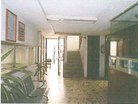
Foto 5. Firmes, muros, losa y escaleras de la primera construcción, en buen estado estructural. Se recomienda poner pasamanos en las escaleras, para evitar accidentes durante la evacuación del inmueble.
