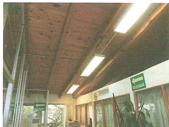
Foto 7. Entrepiso enladrillado y vigas de madera de la segunda construcción, en buen estado estructural.
