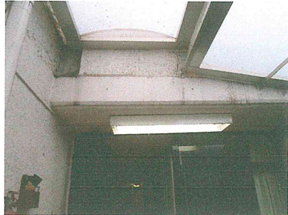
Foto 5. Firmes, muros, losa y escaleras de la primera construcción, en buen estado estructural. Se recomienda poner pasamanos en las escaleras, para evitar accidentes durante la evacuación del inmueble.
