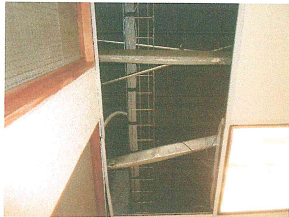
Foto 11. Muro de block, cadenas y castillos de concreto armado del cubo de la escalera, sin afectaciones estructurales.
