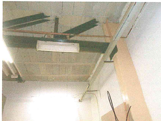
Foto 9 y 10. Muros, columnas metálicas, armaduras de ángulo y entrepiso hecho a base de "vigüeta y bovedilla" ubicados en el taller del Departamento de Mantenimiento, sin afectaciones estructurales. En esta área tampoco tienen afectaciones las instalaciones.
