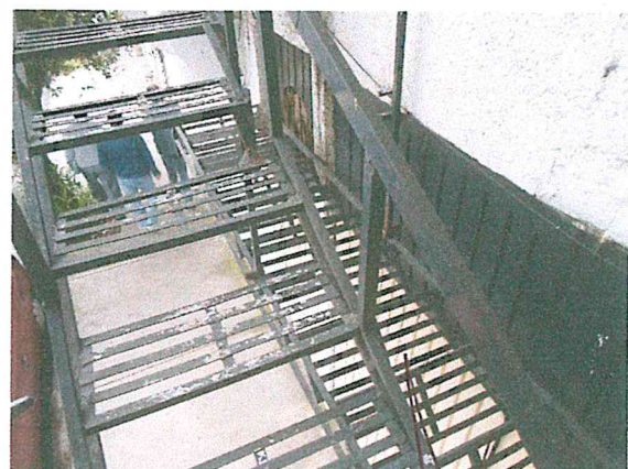
Foto 15 y 16. Escalera levadiza ubicada en la salida de emergencia de la planta alta. Su dimensionamiento, diseño y estructuración, no son funcionales ni seguros.
