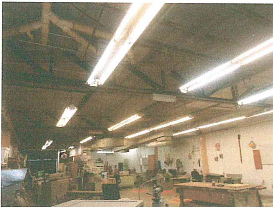
Foto 9 y 10. Muros, columnas metálicas, armaduras de ángulo y entrepiso hecho a base de "vigüeta y bovedilla" ubicados en el taller del Departamento de Mantenimiento, sin afectaciones estructurales. En esta área tampoco tienen afectaciones las instalaciones.
