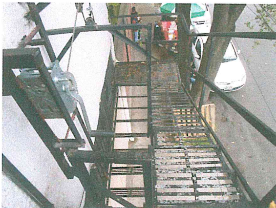
Foto 15 y 16. Escalera levadiza ubicada en la salida de emergencia de la planta alta. Su dimensionamiento, diseño y estructuración, no son funcionales ni seguros.
