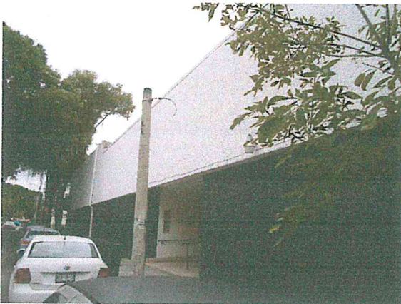
Foto 1. Fachada de acceso al comedor, en buen estado estructural.
