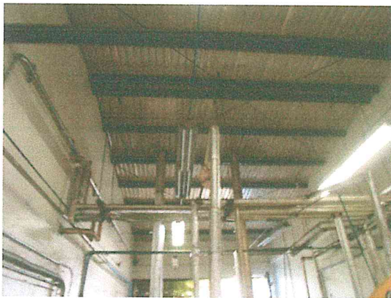
Foto 11. Muros, techumbre de lámina y estructura metálica del área de la casa de máquinas, sin afectación estructural.
