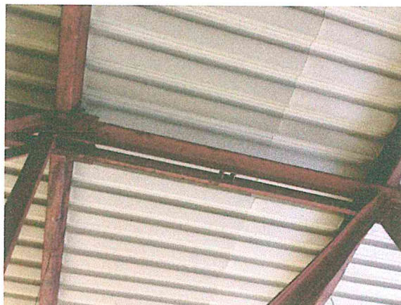
Foto 13 y 14. Estructura metálica de la techumbre del área del comedor, sin afectación estructural. Se recomienda dar el mantenimiento de retiro de óxido y aplicación de pintura.
