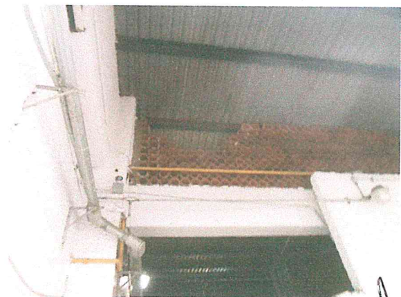
Foto 15 y 16. Celosía hecha de barro recocido en el antepecho de casa de máquinas, con afectaciones. Se recomienda su retiro, ya que las piezas están sueltas y pueden caerse en cualquier momento.
