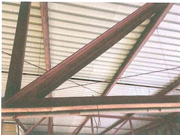
Foto 13 y 14. Estructura metálica de la techumbre del área del comedor, sin afectación estructural. Se recomienda dar el mantenimiento de retiro de óxido y aplicación de pintura.
