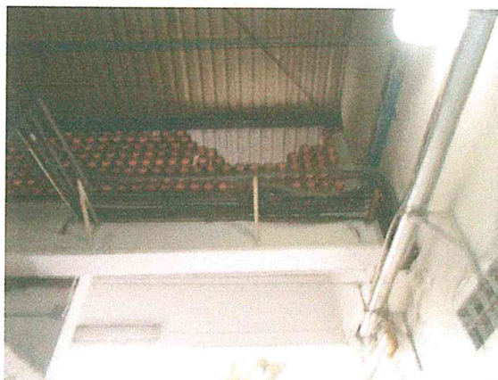
Foto 15 y 16. Celosía hecha de barro recocido en el antepecho de casa de máquinas, con afectaciones. Se recomienda su retiro, ya que las piezas están sueltas y pueden caerse en cualquier momento.
