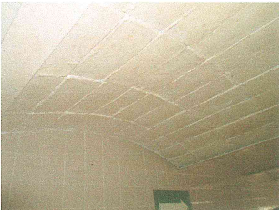
Foto 31. Entrepiso con el sistema de "vigüeta y bovedilla" (acero y ladrillo), ubicado en el entrepiso del sótano del CUERPO PRINCIPAL, en buen estado estructural.
