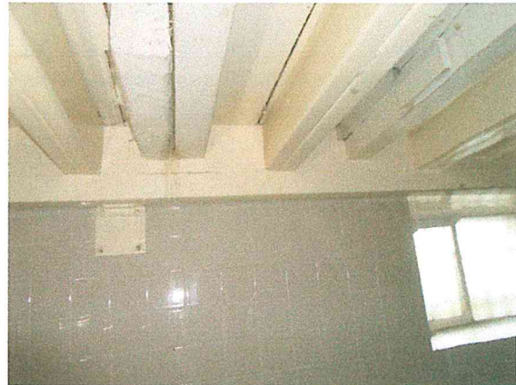
Foto 29 y 30. Entrepiso con vigas de madera reforzado con estructura metálica, ubicado en el entrepiso del sótano del CUERPO PRINCIPAL.
