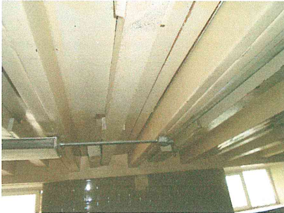
Foto 29 y 30. Entrepiso con vigas de madera reforzado con estructura metálica, ubicado en el entrepiso del sótano del CUERPO PRINCIPAL.
