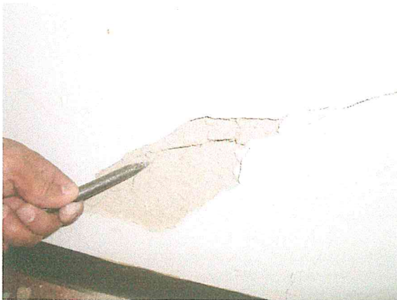
Foto 7 y 8. Fisuras sobre aplanados interiores del CUERPO PRINCIPAL.
