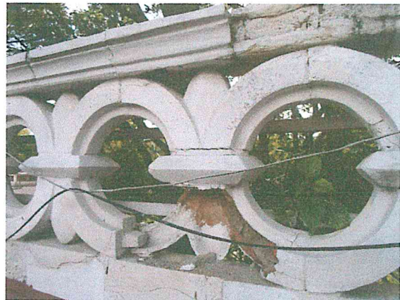
Foto 17 y 18. Afectaciones en las balaustras de la azotea del CUERPO PRINCIPAL. Se debe hacer su reparación y reforzamiento por mano de obra especializada, por tratarse de un edificio catalogado.
