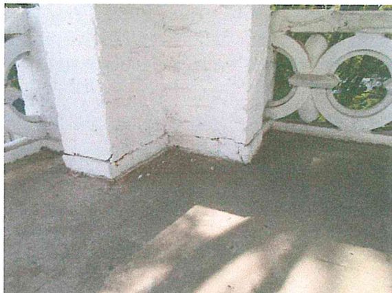
Foto 13 y 14. Afectedión estructural en hiladas de las columnas del KIOSCO DE LA AZOTEA. Se debe hacer su reparación con mano de obra especializada, por tratarse de un edificio histórico.
