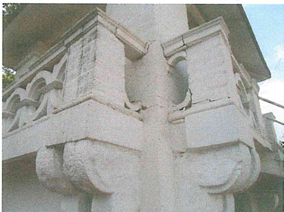
Foto 15. Afectediones en las balaustas del KIOSCO DE LA AZOTEA. Se debe hacer su reparación y reforzamiento por mano de obra especializada, por tratarse de un edificio catalogado.
