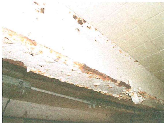
Foto 31. Entrepiso con el sistema de "vigüeta y bovedilla" (acero y ladrillo), ubicado en el entrepiso del sótano del CUERPO PRINCIPAL, en buen estado estructural.
