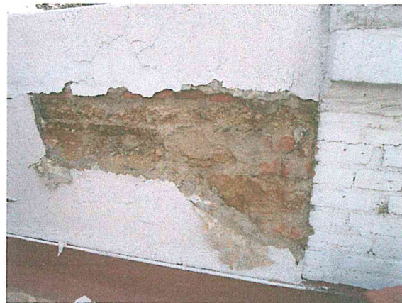
Foto 19 y 20. Afectaciones en el pretil de la azotea del CUERPO PRINCIPAL. Se debe hacer su reparación y reforzamiento por mano de obra especializada, por tratarse de un edificio catalogado.
