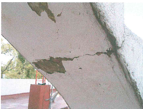
Foto 15. Afectediones en las balaustas del KIOSCO DE LA AZOTEA. Se debe hacer su reparación y reforzamiento por mano de obra especializada, por tratarse de un edificio catalogado.
