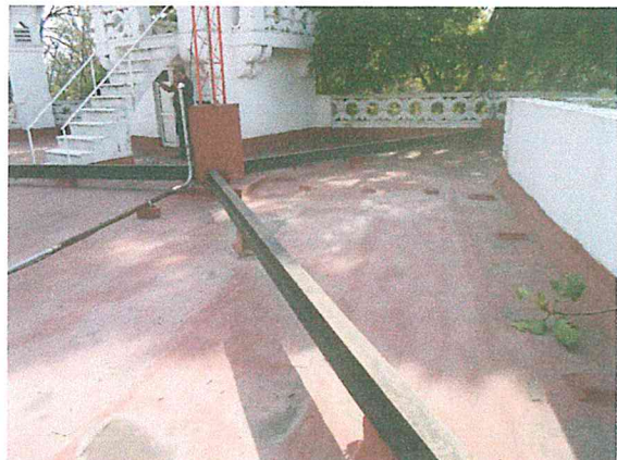
Foto 21. Columnata ubicada en la azotea del CUERPO PRINCIPAL, sin afectaciones estructurales. Se recomienda sujetarla para garantizar su verticalidad ante un eventual próximo sismo.
