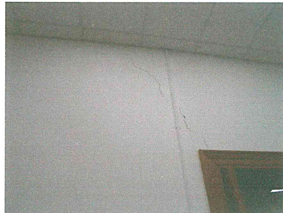
Foto 7 y 8. Fisuras sobre aplanados interiores del CUERPO PRINCIPAL.
