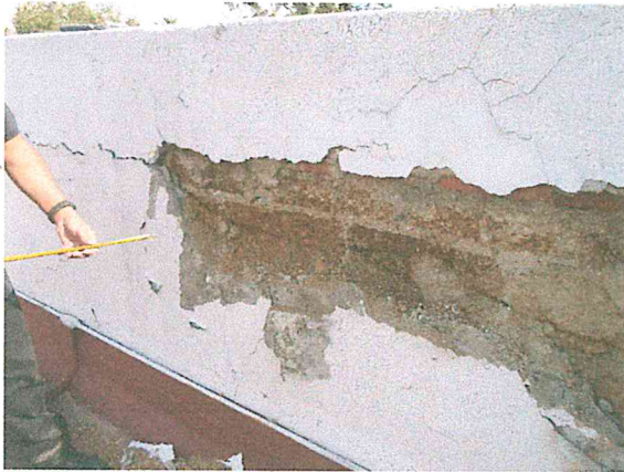
Foto 19 y 20. Afectaciones en el pretil de la azotea del CUERPO PRINCIPAL. Se debe hacer su reparación y reforzamiento por mano de obra especializada, por tratarse de un edificio catalogado.
