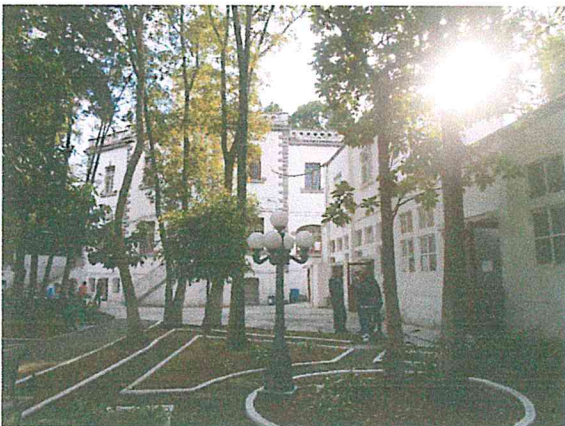
Foto 35. Circulaciones y áreas verdes del conjunto, sin afectaciones.
