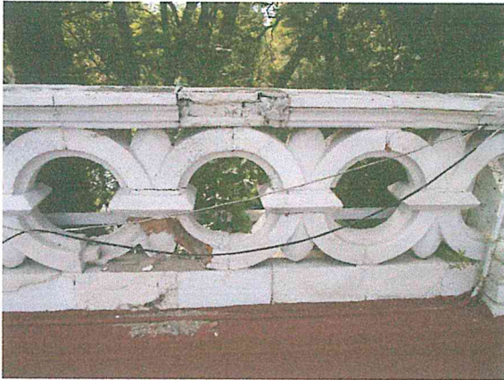
Foto 17 y 18. Afectaciones en las balaustras de la azotea del CUERPO PRINCIPAL. Se debe hacer su reparación y reforzamiento por mano de obra especializada, por tratarse de un edificio catalogado.
