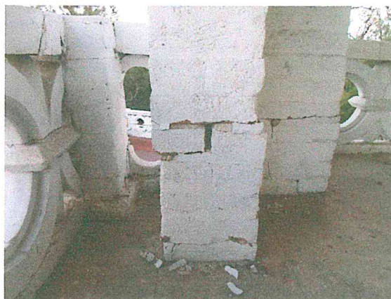
Foto 13 y 14. Afectedión estructural en hiladas de las columnas del KIOSCO DE LA AZOTEA. Se debe hacer su reparación con mano de obra especializada, por tratarse de un edificio histórico.
