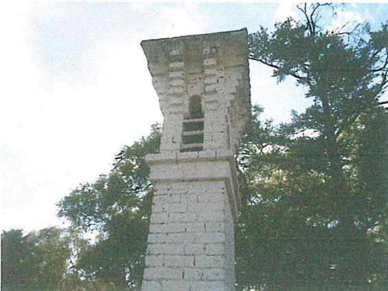
Foto 21. Columnata ubicada en la azotea del CUERPO PRINCIPAL, sin afectaciones estructurales. Se recomienda sujetarla para garantizar su verticalidad ante un eventual próximo sismo.
