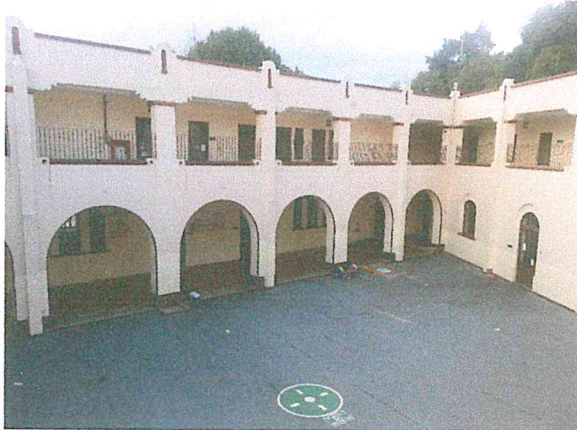
Foto 9. Columnas, arcos y antepechos del patio de la casa hogar para niños, en buen estado estructural. Foto 10. Vigas de acero y perfiles metálicos de la techumbre de acceso a la casa hogar para niños, en buen estado estructural.
