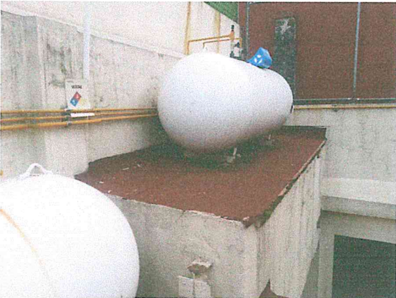
Foto 15 y 16. Tanque de gas ubicado en la zona de acceso de suministros, apoyado sobre una losa inclinada. Se recomienda complementar su fijación con elementos adicionales sujetos al muro. Lo anterior para evitar su probable caída durante algún eventual movimiento sísmico.
