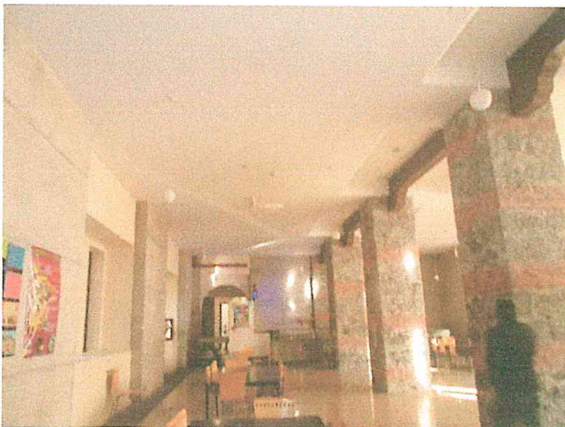
Foto 5. Muros de concreto, columnas de piedra, vigas de madera, plafones y pisos del comedor de la casa hogar para varones, sin afectación estructural.
