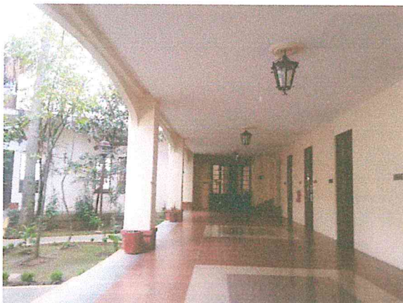
Foto 3. Columnas, arcos, entrepiso y firmes del pasillo de la casa hogar para varones, sin afectación estructural.
