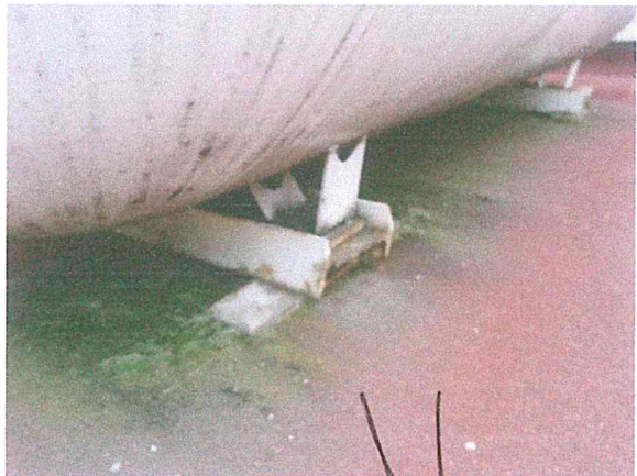
Foto 15 y 16. Tanque de gas ubicado en la zona de acceso de suministros, apoyado sobre una losa inclinada. Se recomienda complementar su fijación con elementos adicionales sujetos al muro. Lo anterior para evitar su probable caída durante algún eventual movimiento sísmico.
