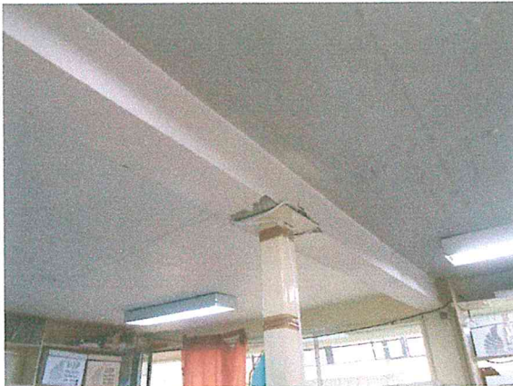
Foto 17. Placa y PTR de refuerzo para trabe en el área de Protección Civil. Se recomienda verificar la correcta unión de los elementos para garantizar su apoyo.
