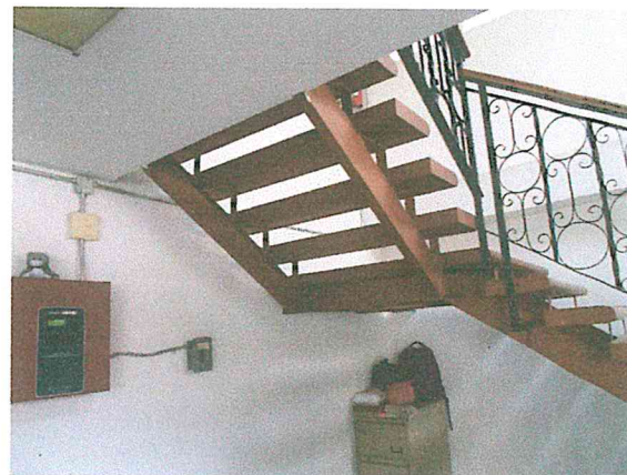
Foto 31 y 32. Escalera del área de Servicios Generales, hecha a base de estructura metálica, en buen estado estructural. Se recomienda poner el otro "pasa manos" por el lado del muro, para evitar caídas durante una evacuación.
