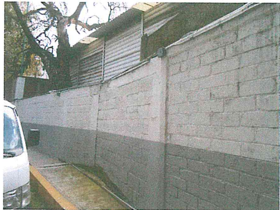
Foto 25 y 26. Barda de colindancia próxima a la caseta de acceso vehicular, que presenta una incineración. Se recomienda su restitución.
