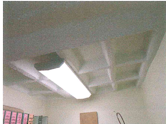
Foto 9. Nervaduras invertidas con acero pretensado, correspondiente a la techumbre de la Dirección de Administración Patrimonial, en buen estado estructural.
