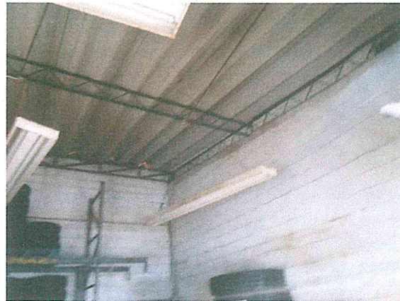
Foto 11. Traves, columnas y losa de vigueta y bovedilla de la oficina adyacente del área de protección civil, en buen estado estructural.
