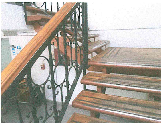
Foto 31 y 32. Escalera del área de Servicios Generales, hecha a base de estructura metálica, en buen estado estructural. Se recomienda poner el otro "pasa manos" por el lado del muro, para evitar caídas durante una evacuación.
