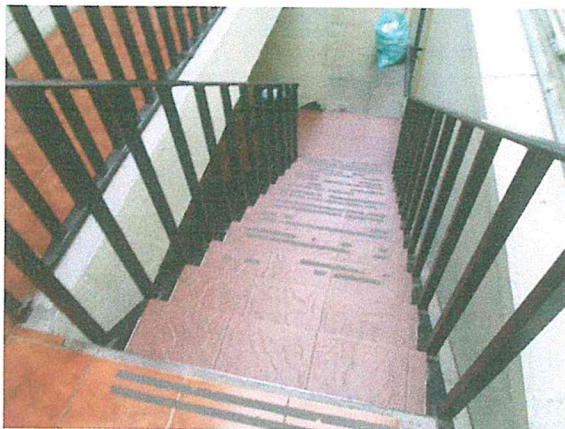
Foto 29. Escalera del área de Protección Civil, hecha a base de estructura metálica y escalones prefabricados, en buen estado.
