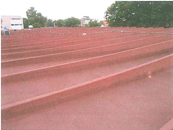
Foto 9. Nervaduras invertidas con acero pretensado, correspondiente a la techumbre de la Dirección de Administración Patrimonial, en buen estado estructural.
