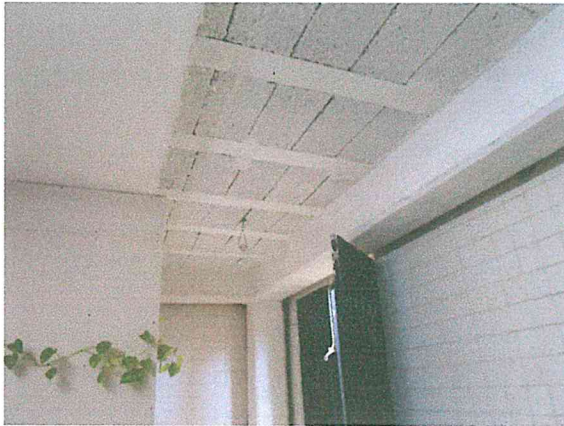
Foto 11. Traves, columnas y losa de vigueta y bovedilla de la oficina adyacente del área de protección civil, en buen estado estructural.
