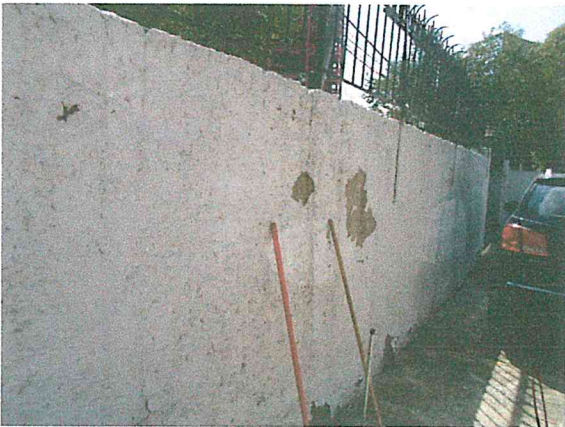
Foto 19 y 20. Bandas de colindancia en buen estado estructural.
