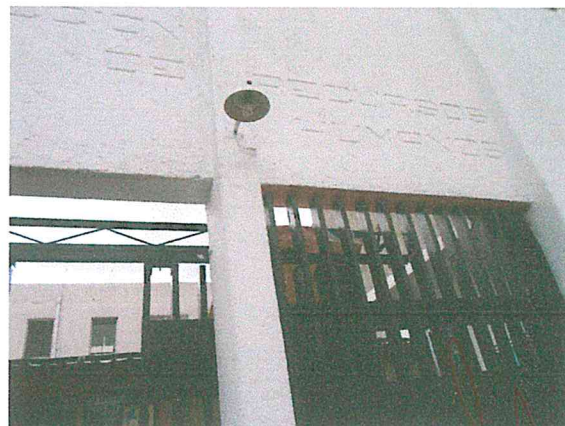
Foto 2. Columnas y antepechos del acceso secundario, en buen estado estructural.
