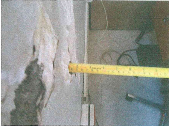
Foto 13. Aplanado afectado por la humedad. Se recomienda su atención para evitar que a largo plazo se afecten elementos estructurales.
