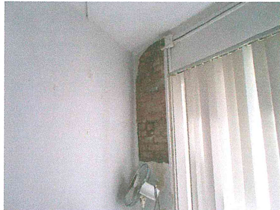
Foto 13. Aplanado afectado por la humedad. Se recomienda su atención para evitar que a largo plazo se afecten elementos estructurales.
