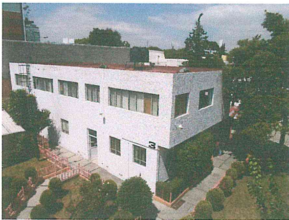
Foto 3. Estructura del cuerpo número 3, en buen estado estructural.
