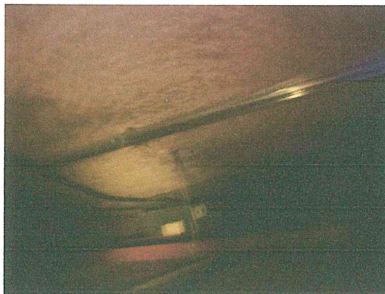
Foto 11. Cadena afectada por el paso de instalaciones, ubicada en la oficina de la izquierda de la casa número 2. Se recomienda su reparación y refuerzo. La losa está en buen estado estructural.
