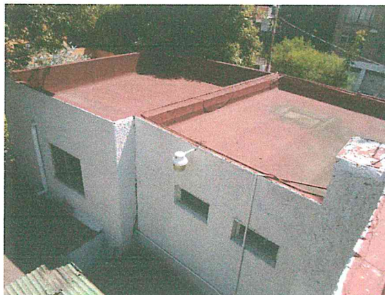
Foto 9 y 10. Losas de azotea del cuerpo número 1, en buen estado estructural.
