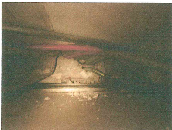
Foto 11. Cadena afectada por el paso de instalaciones, ubicada en la oficina de la izquierda de la casa número 2. Se recomienda su reparación y refuerzo. La losa está en buen estado estructural.
