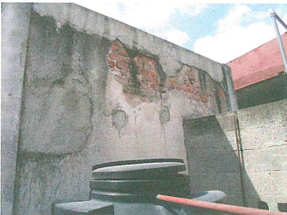
Foto 15. Aplanado de pretil de azotea del cuerpo 4, afectado por la humedad, situación que no representa ningún riesgo estructural.
