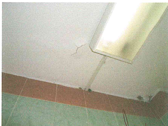
Foto 15. Aplanado de pretil de azotea del cuerpo 4, afectado por la humedad, situación que no representa ningún riesgo estructural.
