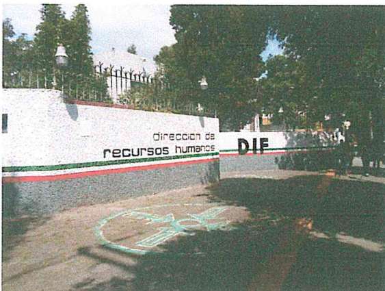
Foto 1. Bardas del acceso principal, en buen estado estructural.
