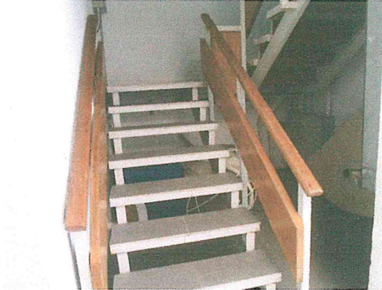
Foto 7. Escaleras del edificio de aulas, en buen estado estructural.
