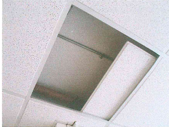
Foto 8. Losa de entrepiso del edificio de aulas, en buen estado estructural.
