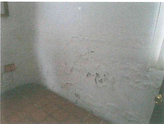
Foto 11 y 12. Presentación de humedad en los muros del sótano. Se debe aislar el origen del agua para evitar que la cimentación, el firme y los muros se sigan afectando.
