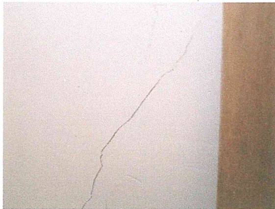
Foto 9 y 10. Aparición de fisura en el muro de un closet. Aparentemente se vio alcanzado el material base. Se recomienda su refuerzo con castillos intermedios anclados a la cadena y losa existente, así como la restitución de todo el aplanado con refuerzo de malla electrosoldada.
