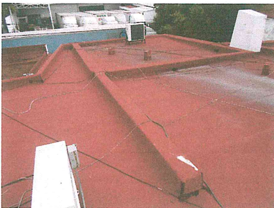
Foto 3 y 4. Losas de azotea y base del tinaco de la DIRECCIÓN DE COMUNICACIÓN SOCIAL, sin afectaciones estructurales.
