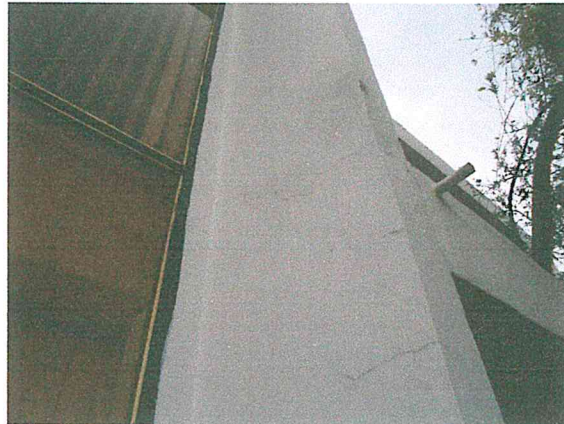
Foto 14. Aparición de fisuras "por temperatura" en los aplanados de las fachadas. Se recomienda su sellado y aplicación general de pintura. Lo anterior para poder detectar probables fisuras de futuros movimientos sísmicos.
