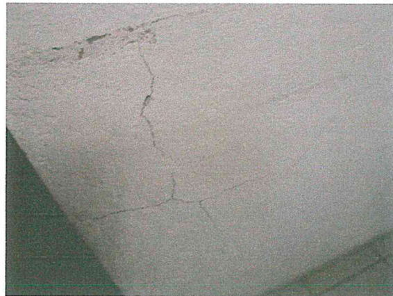
Foto 7. Aplanado desprendido en un cerramiento de la fachada posterior. Se recomienda su restitución con reforzamiento, por protección del elemento estructural.
