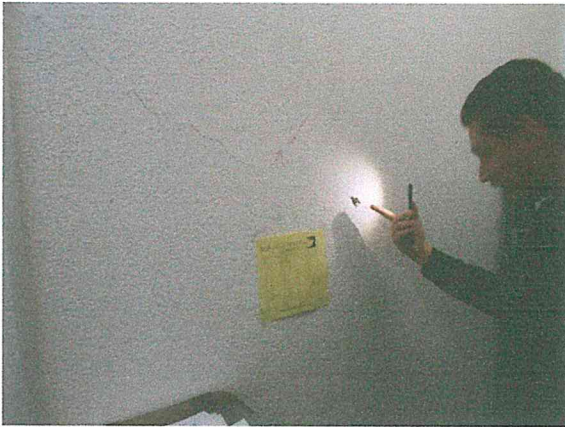
Foto 9 y 10. Aparición de fisura en el muro de un closet. Aparentemente se vio alcanzado el material base. Se recomienda su refuerzo con castillos intermedios anclados a la cadena y losa existente, así como la restitución de todo el aplanado con refuerzo de malla electrosoldada.
