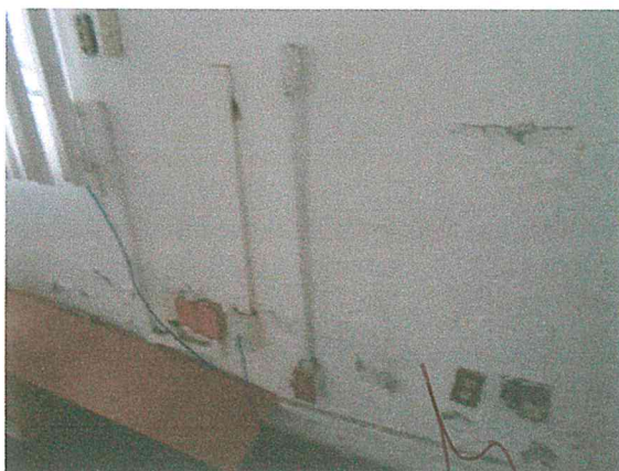
Foto 11 y 12. Presentación de humedad en los muros del sótano. Se debe aislar el origen del agua para evitar que la cimentación, el firme y los muros se sigan afectando.
