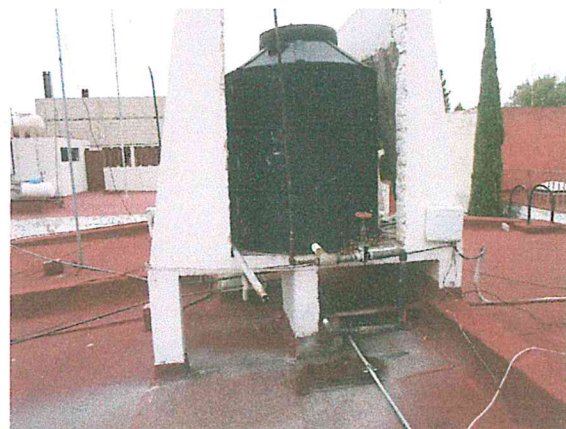
Foto 3 y 4. Losas de azotea y base del tinaco de la DIRECCIÓN DE COMUNICACIÓN SOCIAL, sin afectaciones estructurales.
