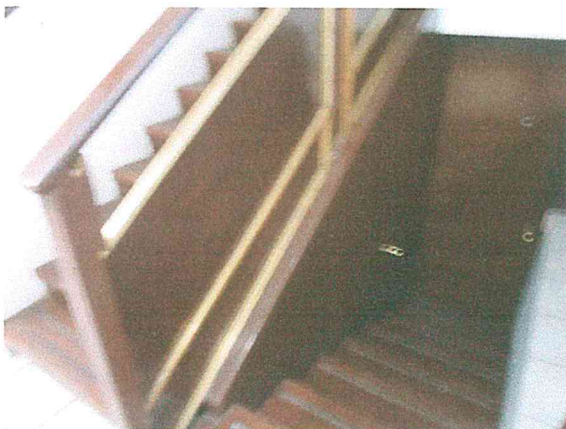
Foto 5 y 6. Escalera de servicio normal hecha a base de madera, sin afectaciones estructurales.
