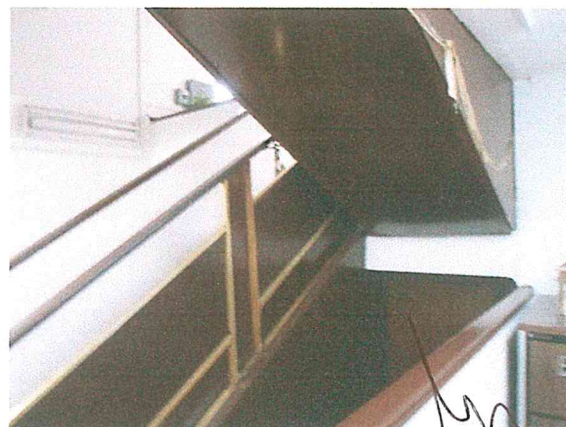
Foto 5 y 6. Escalera de servicio normal hecha a base de madera, sin afectaciones estructurales.
