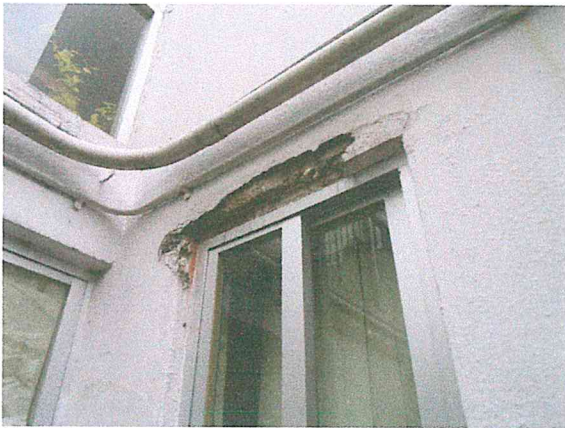
Foto 7. Aplanado desprendido en un cerramiento de la fachada posterior. Se recomienda su restitución con reforzamiento, por protección del elemento estructural.
