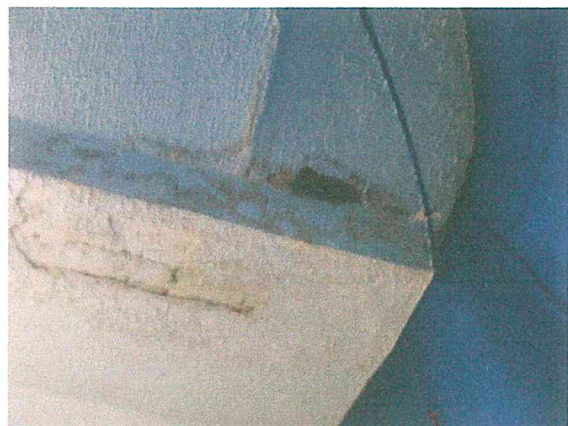
Foto 19. Cubierta de losa prefabricada en W de concreto armado del AUDITORIO, en buenas condiciones estructurales.
