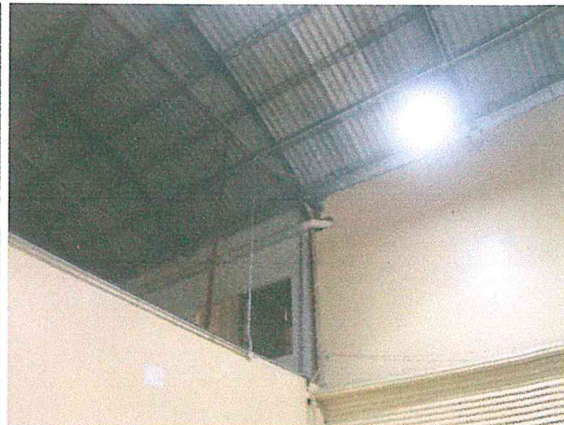
Foto 6. Muros, estructura y cubierta de ALMACEN en buenas condiciones estructurales.
