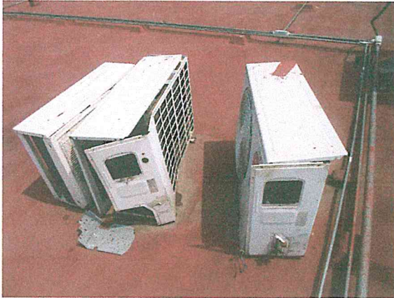
Foto 13. Se recomienda retirar equipo en desuso existente en la azotea para evitar carga muerta.
