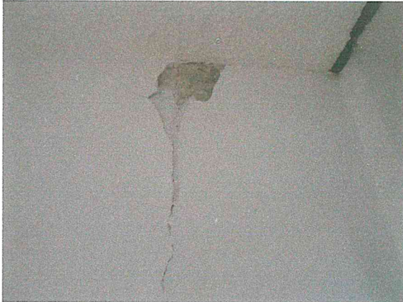
Foto 15. Fisura en acabados que no representan ningún riesgo. Se recomienda su sellado por impacto visual con los usuarios.
