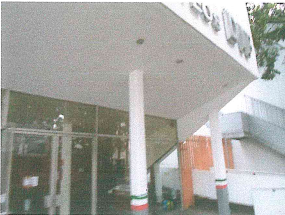
Foto 23. Se aprecia que las columnas del vestíbulo del AUDITORIO son de una sección reducida. Se recomienda verificar las características y estructuración de la losa, ya que no se aprecian traveses.
