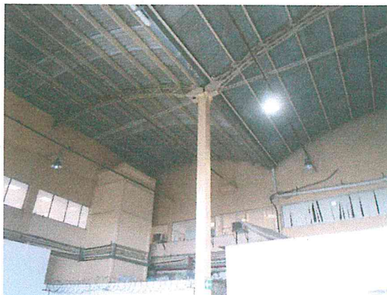
Foto 7. Sistema de entresado de "losacero" del edificio de OFICINAS, en buenas condiciones. Foto 8. Estructura metálica y techumbre de asbesto de ALMACEN, en buenas condiciones.
