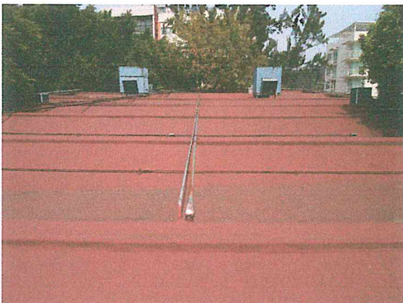
Foto 19. Cubierta de losa prefabricada en W de concreto armado del AUDITORIO, en buenas condiciones estructurales.
