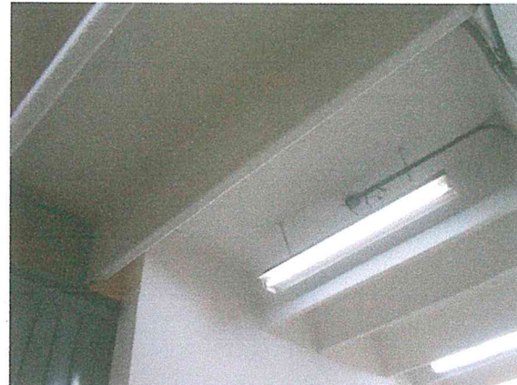
Foto 21. Se detectaron desperfectos de origen en losas de concreto armado, derivado de la falta de vibrado en el momento del colado. Por tratarse de casos aislados, no representan ningún riesgo estructural.
