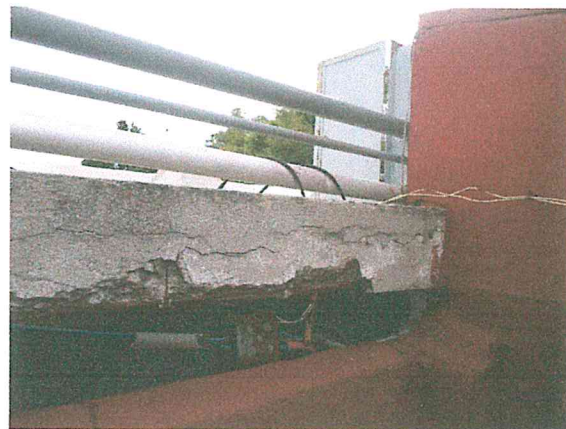
Foto 7 y 8. Trabe de liga de concreto armado ubicada en la azotea de la DIRECCIÓN DE ADQUISICIONES, dañada por la intemperie. Se recomienda su reforzamiento y reparación para garantizar su funcionamiento estructural.
