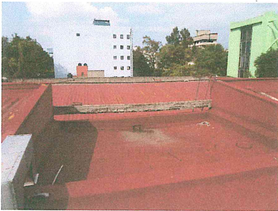
Foto 7 y 8. Trabe de liga de concreto armado ubicada en la azotea de la DIRECCIÓN DE ADQUISICIONES, dañada por la intemperie. Se recomienda su reforzamiento y reparación para garantizar su funcionamiento estructural.
