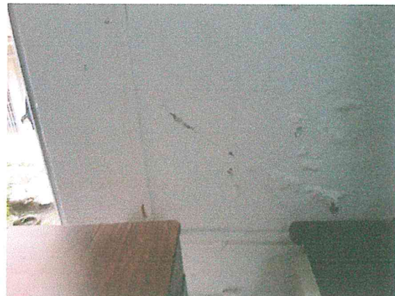
Foto 11. Fisura en el muro lateral del auditorio de la DIRECCIÓN DE ADQUISICIONES. Esta fisura no representan ningún riesgo estructural sin embargo se recomienda su sellado.
