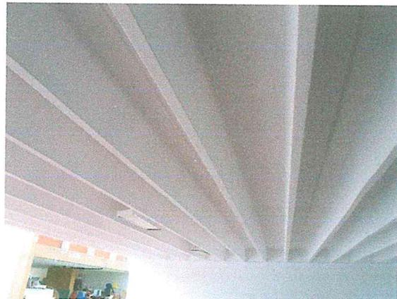
Foto 4. Losa nervada prefabricada tipo, sin afectaciones estructurales en ninguno de los doce edificios.
