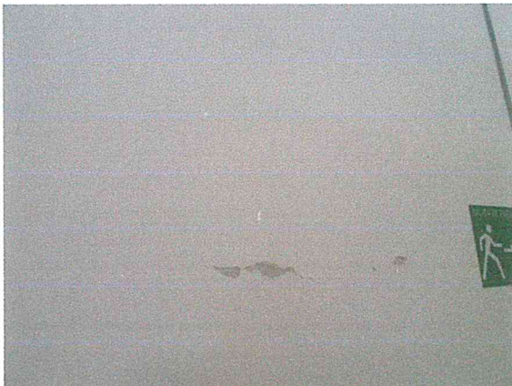
Foto 5 y 6. Marcación de fisuras superficiales sobre los aplanados de los muros divisorios de block del cubo de la escalera, mismas que no representan riesgo estructural alguno.
