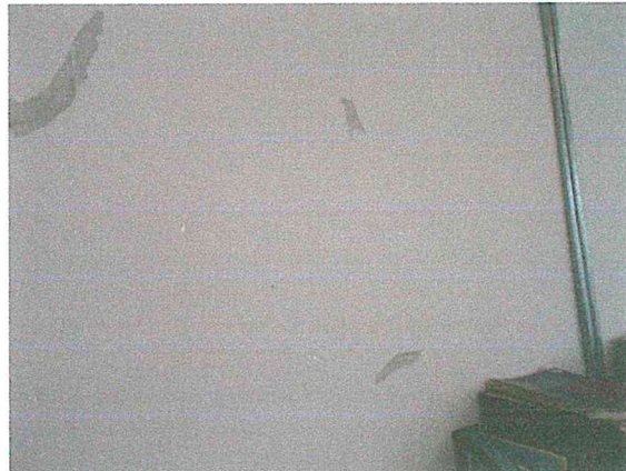
Foto 5 y 6. Marcación de fisuras superficiales sobre los aplanados de los muros divisorios de block del cubo de la escalera, mismas que no representan riesgo estructural alguno.
