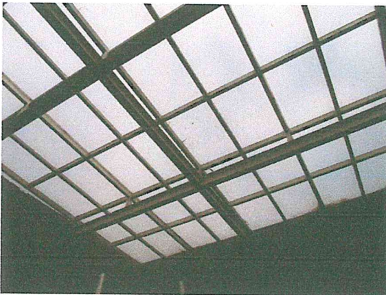
Foto 7. Vigas de acero del domo del cubo de la escalera, sin afectaciones estructurales.
