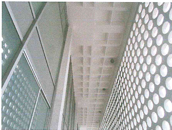
Foto 3. Columnas, losa reticular y celosía, sin afectaciones estructurales.
