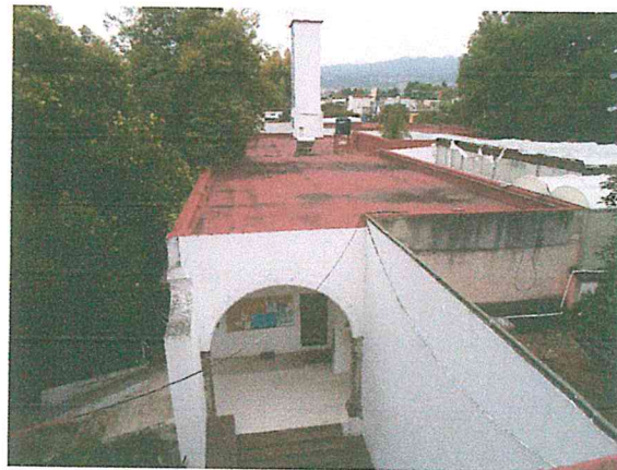
Foto 6. Losa de concreto de techumbre del PRIMER CUERPO, sin afectaciones estructurales.
