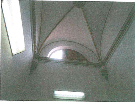
Foto 15. Bóvedas de la Dirección de Protección a la Infancia, en buen estado estructural.
