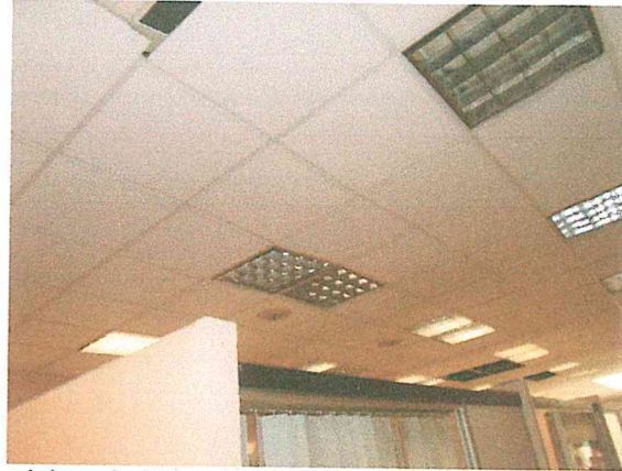
Foto 10. Suspensión del plafón modular deformada por el sismo, en la Dirección de Profesionalización.
