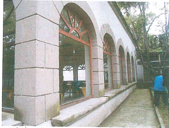
Foto 20. Elementos de la fachada del comedor, en buen estado estructural.
