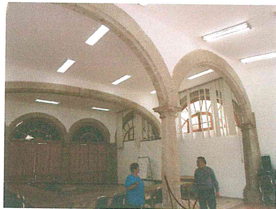
Foto 18. Columnas y arcos de cantera de la Dirección de Protección a la Infancia, en buen estado estructural.
