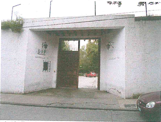
Foto 1. Barda de acceso al predio, sin afectaciones estructurales.
