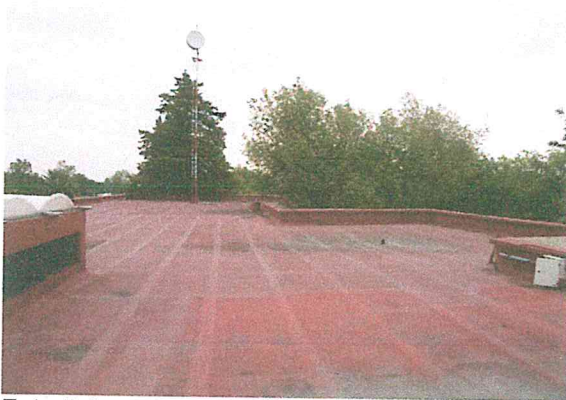
Foto 5. Losa de concreto de techumbre del SEGUNDO CUERPO, sin afectaciones estructurales.
