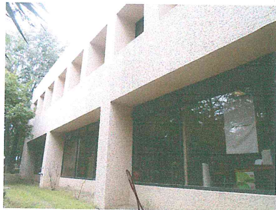
Foto 2. Fachada del SEGUNDO INMUEBLE (Dir. Profesionalización), sin afectaciones estructurales.
