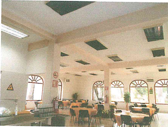
Foto 19. Columnas, traves y losas del comedor, en buen estado estructural.
