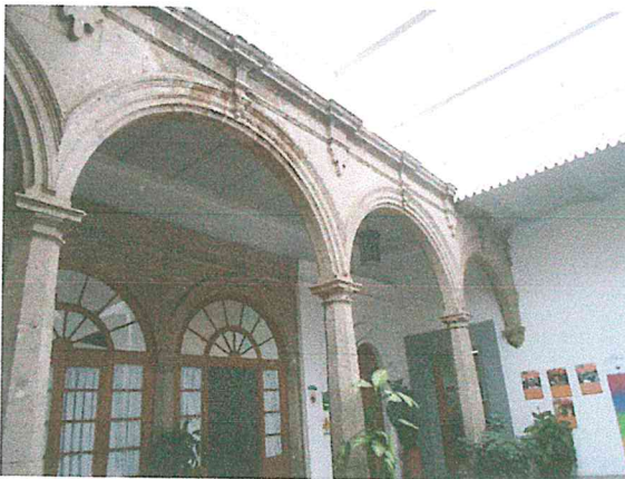
Foto 13. Arcos y columnas de cantera, en buen estado estructural.
