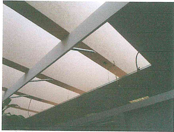
Foto 8. Zona del plafón modular que se desplomo completa en la Dirección de Profesionalización.
