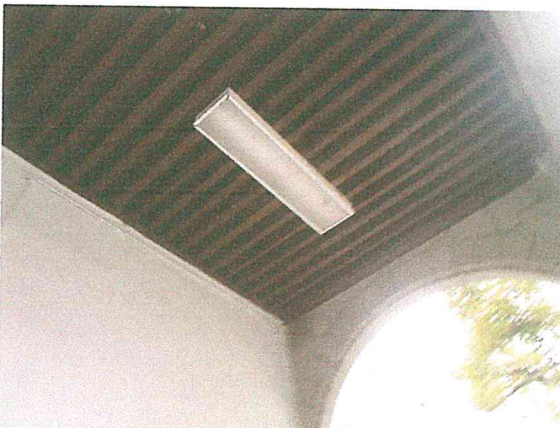
Foto 17. Vigas de madera de la Dirección de Protección a la Infancia, en buen estado estructural.
