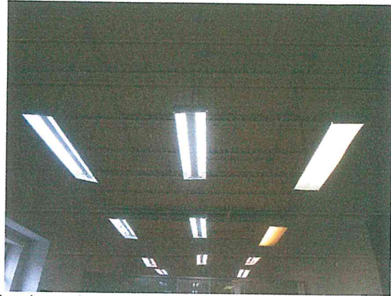
Foto 16. Techumbre de vigueta y lámina ondulada, en buen estado estructural.
