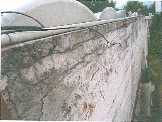
Foto 9. Zona de la azotea por donde se filtra el agua pluvial, en la Dirección de Profesionalización.
