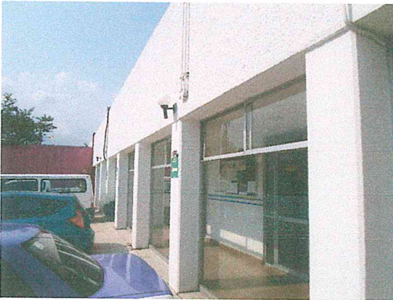
Foto 3. Columnas y faldones de concreto armado, sin afectaciones estructurales.
