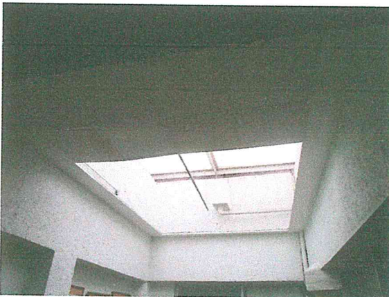
Foto 5. Zona del domo de terapia física, donde el plafón modular se desplomo con todo y lámpara durante el sismo. Se recomienda quitar este plafón, ya que además tapa una fuente de iluminación natural.
