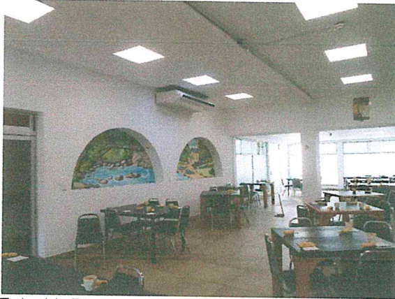
Foto 11. Pisos, muros y plafones del área del comedor, sin afectaciones estructurales.
