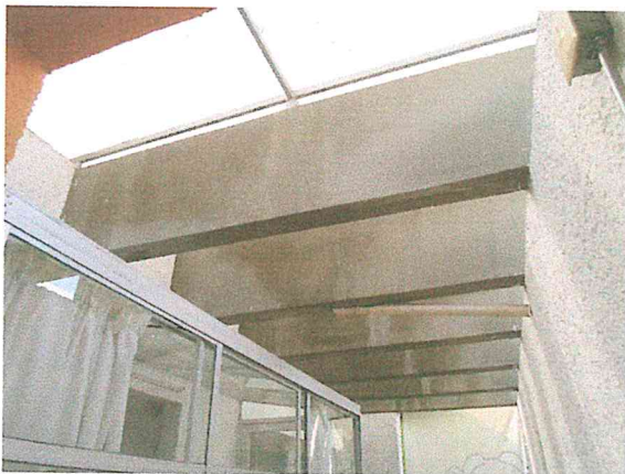
Foto 9. Muros y travesaños de la zona de la dirección, sin afectaciones estructurales.
