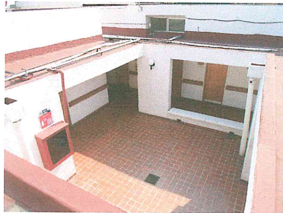
Foto 3. Columnas y faldones de concreto armado, sin afectaciones estructurales.
