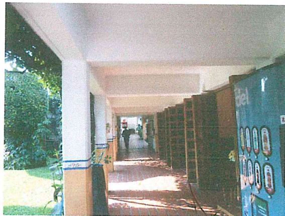
Foto 5. Zona del domo de terapia física, donde el plafón modular se desplomo con todo y lámpara durante el sismo. Se recomienda quitar este plafón, ya que además tapa una fuente de iluminación natural.
