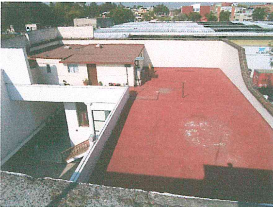
Foto 13. Se observa que en la azotea hay una construcción ajena al edificio original. Se recomienda hacer un análisis de la carga que representa, para evaluar el riesgo estructural que podría representar. Foto 14. Escalera de estructura metálica, en buen estado estructural.
