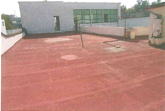
Foto 7. Losa plana de azotea, sin afectaciones estructurales.
