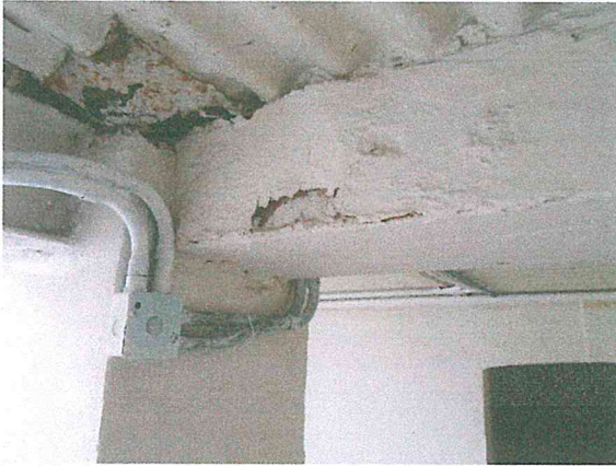
Foto 11. Afectación por humedad en una esquina del entrepiso del sótano. Se recomienda su reparación. Foto 12. Barda de colindancia, a pesar de su excesiva altura, está en buen estado estructural.
