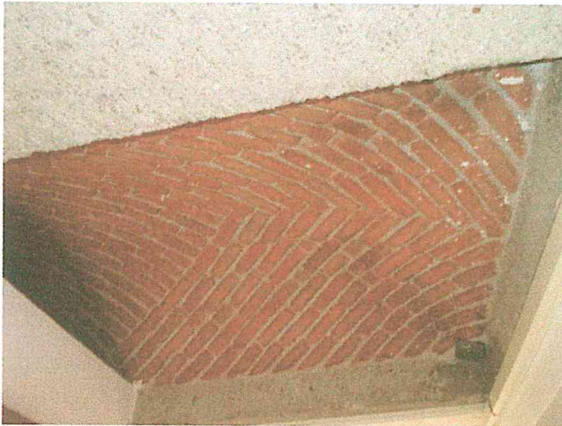
Foto 13. Bóveda de tabique como sistema de techumbre en el edificio C, sin afectaciones estructurales.
