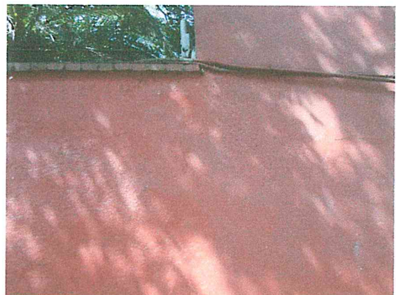
Foto 15. Barda frontal ligeramente desplazada a raíz del sismo. De acuerdo a su verticalidad, no tiene riesgo de caída, pero se recomienda realizar algún refuerzo de sujeción.
