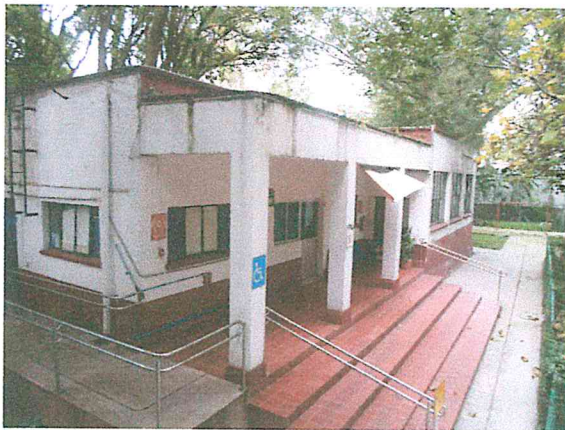
Foto 7. Columnas, traves, muros y firmes del Edificio B, sin afectaciones estructurales.
