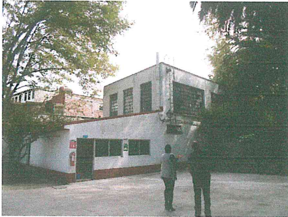
Foto 11. Muros del Edificio C, sin afectaciones estructurales.
