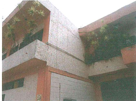
Foto 9. Escaleras de oficinas del Almacén Central, hechas a base de concreto armado, sin afectación estructural.
