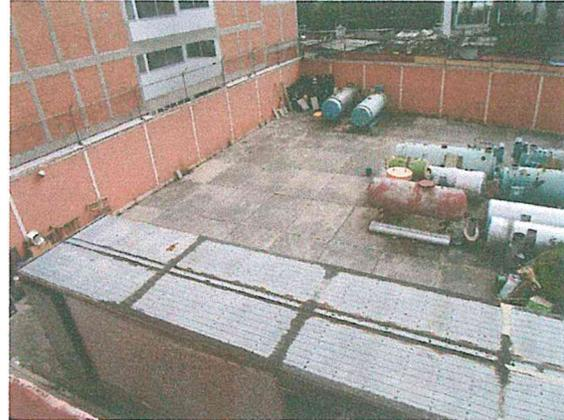
Foto 7. Techumbre a base de losas planas de concreto armado del Almacén Central, sin afectaciones estructurales.
