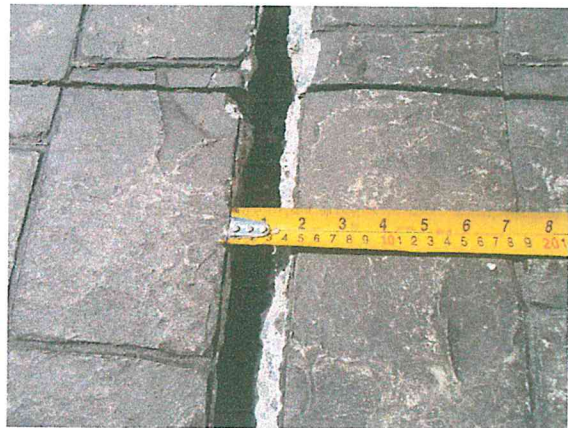
Foto 9 y 10. Sobre posición y separación de firmes de concreto, derivado del movimiento sísmico. Se deben hacer las nivelaciones necesarias al terreno y restituir los firmes afectados.
