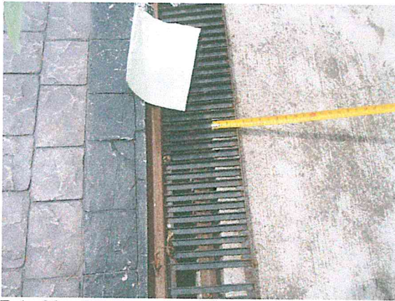
Foto 23 y 24. Zona de rejillas pluviales afectadas por la sobre posición de los firmes durante el sismo. Se deberán hacer las reparaciones necesarias en los firmes y los ajustes a que haya lugar en las rejillas.
