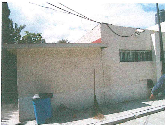
Foto 33 y 34. En el cuerpo que alberga el servicio de terapia física, se marcó la junta constructiva natural de las dos construcciones pegadas, misma que no representa ningún riesgo estructural.
