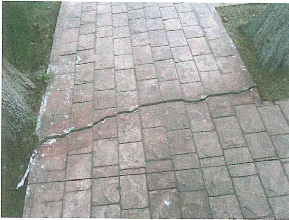
Foto 7 y 8. Grietas en firmes de circulaciones del conjunto, que se presentaron a raíz del movimiento de terreno. Se deben hacer las nivelaciones necesarias al terreno y restituir los firmes afectados.
