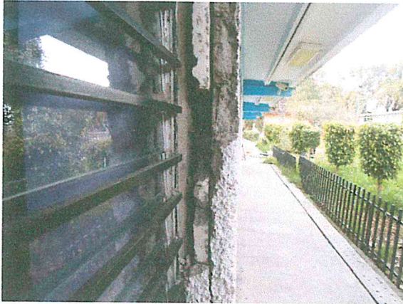
Foto 27 y 28. Se debe evitar poner aplastados gruesos y menos poner uno sobre otro, ya que se convierten en piedras susceptibles de caer sin control.
