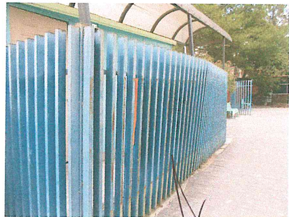
Foto 29 y 30. Puerta caída y reja flexionada por las afectaciones a los firmes de concreto. Se deben hacer las reparaciones necesarias, en especial a la puerta, para que se permita su abatimiento.
