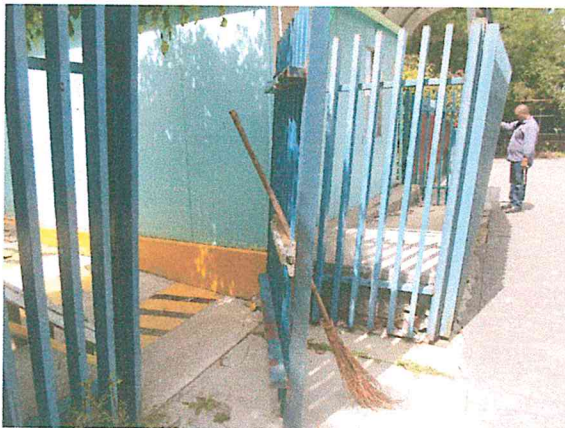
Foto 29 y 30. Puerta caída y reja flexionada por las afectaciones a los firmes de concreto. Se deben hacer las reparaciones necesarias, en especial a la puerta, para que se permita su abatimiento.
