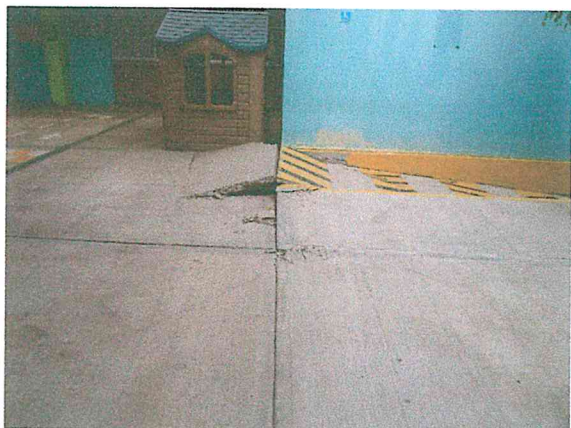
Foto 31 y 32. Afectaciones en firmes y rampas de concreto. Se deben hacer sus reparaciones para evitar accidentes de caídas con los usuarios.
