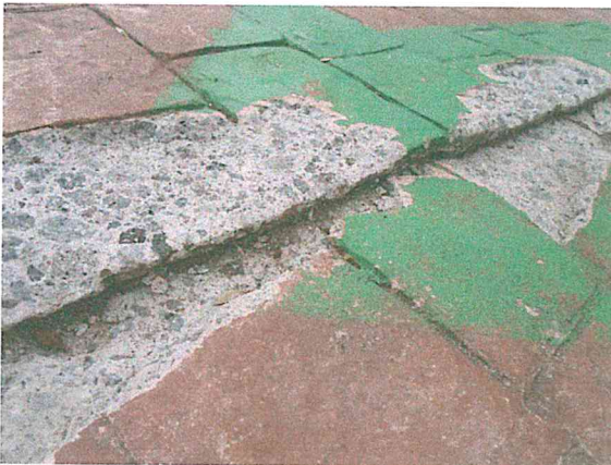
Foto 9 y 10. Sobre posición y separación de firmes de concreto, derivado del movimiento sísmico. Se deben hacer las nivelaciones necesarias al terreno y restituir los firmes afectados.
