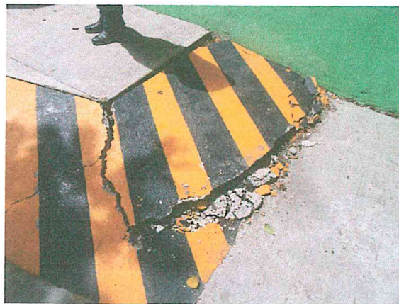
Foto 31 y 32. Afectaciones en firmes y rampas de concreto. Se deben hacer sus reparaciones para evitar accidentes de caídas con los usuarios.
