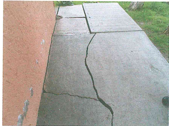
Foto 7 y 8. Grietas en firmes de circulaciones del conjunto, que se presentaron a raíz del movimiento de terreno. Se deben hacer las nivelaciones necesarias al terreno y restituir los firmes afectados.
