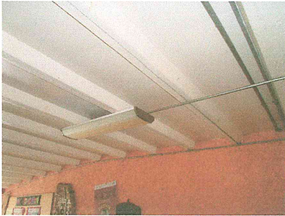
Foto 3. Estructuración típica de la losa que se emplea en todos los cuerpos, a base de módulos en forma de "C", donde el principal apoyo son las nervaduras de la losa.
