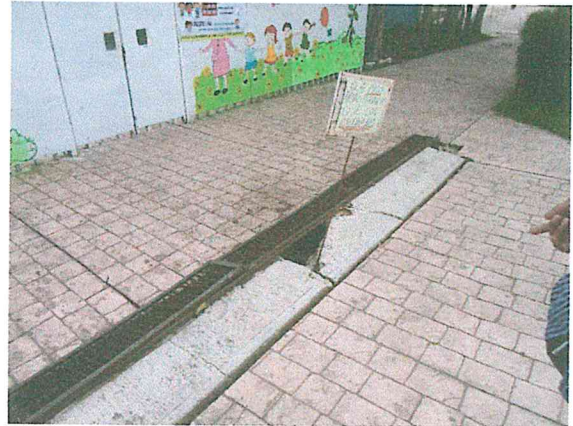
Foto 23 y 24. Zona de rejillas pluviales afectadas por la sobre posición de los firmes durante el sismo. Se deberán hacer las reparaciones necesarias en los firmes y los ajustes a que haya lugar en las rejillas.
