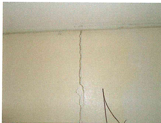
Foto 33 y 34. En el cuerpo que alberga el servicio de terapia física, se marcó la junta constructiva natural de las dos construcciones pegadas, misma que no representa ningún riesgo estructural.
