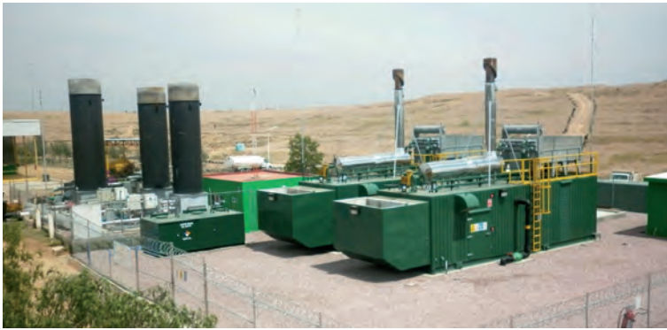
Figura 7.3. Fotografía del área de tratamiento de biogás y generación eléctrica (cortesía ENER-G Natural Power).
