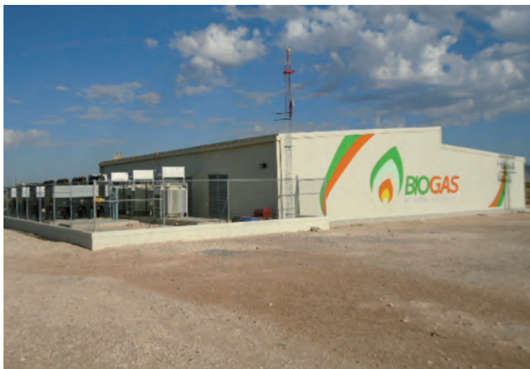
Figura 7.5. Fotografía de la instalación (cortesía Biogás de Juárez).
