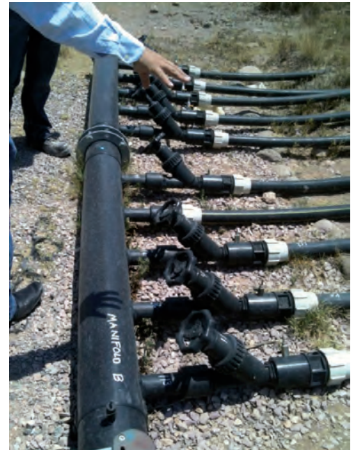
Figura 7.4. Cabezal de captación de biogás en el relleno sanitario.
