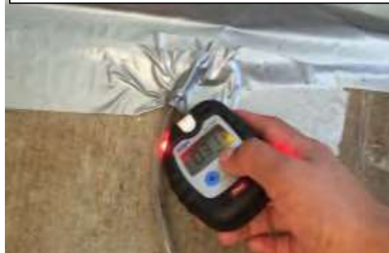
Imagen 8. Detección de fugas de fosfina con equipo “Dräger Pac 7000”
