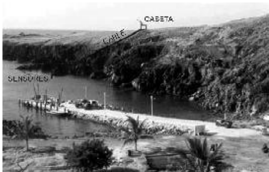
Fig. 22. Bahía Vargas Lozano, Isla Socorro, 1991. Se indica el lugar en donde se instaló la caseta del mareógrafo y el lugar en donde se instalaron los sensores de la estación.
