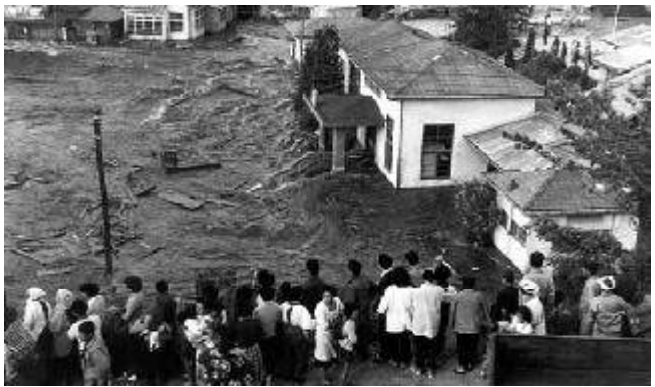
Fig. 18. Daños causados por el Tsunami en Chile en 1960. Fuente: www.pubs.usgs.gov/circ/c1187/images/coverphoto.jpg
