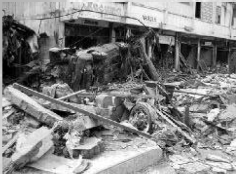
Fig. 46. Daños y depósitos de escombros entre 1 y 2.5 km a partir de la costa. Fuente: CENAPRED
