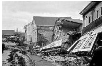
Fig. 5. Daños a viviendas causados por el Tsunami en Chile en 1960.
