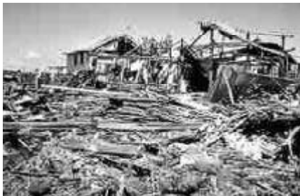
Fig. 4. Daños causados por el tsunami frente a Nicaragua el 2 de septiembre de 1992. Fuente: www.earthfiles.com/images/new/N/NicaraguaEathquaker1993a.jpg
