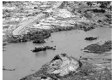
Fig. 48. Infraestructura de Banda Aceh afectada por el tsunami. Fuente: www.bbc.co.uk/portuguese/especial/
