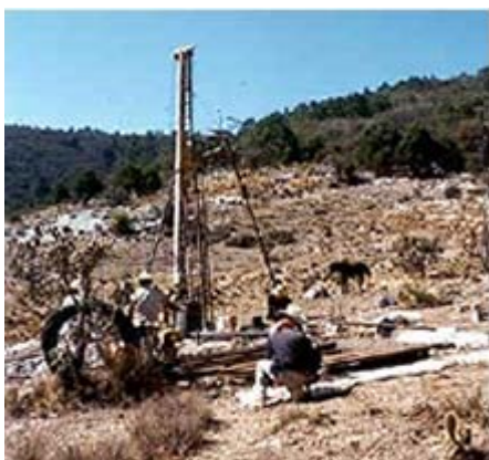
Perforación con broca diamantada y recuperación de núcleo
