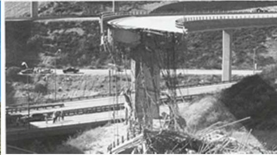
Puente destruido por un terremoto
