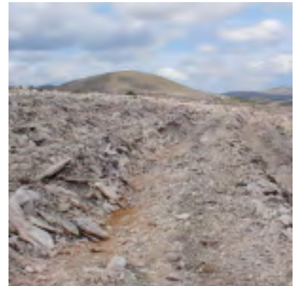
Obras de conservación de suelos y captación de agua de lluvia en curvas a nivel.
