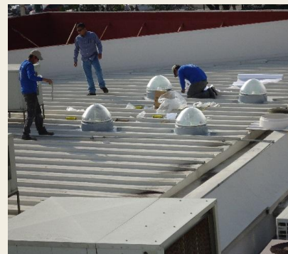
Instalación de luminarias solares y área iluminada
