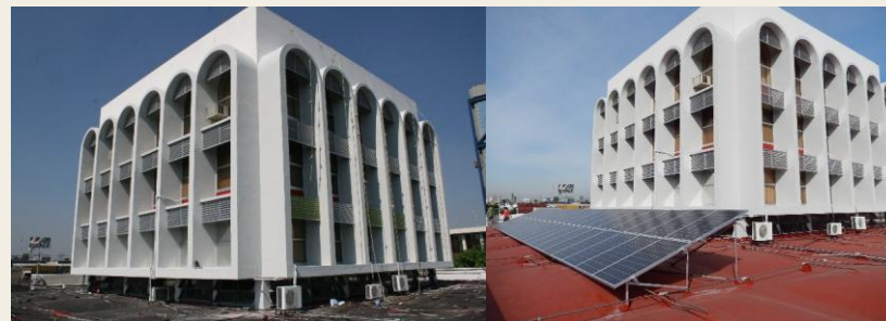
Antes y después de la instalación del sistema fotovoltaico
