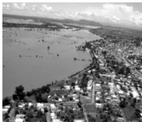
Fig. 43. Bordo longitudinal sobre el río Santiago , Nay.
