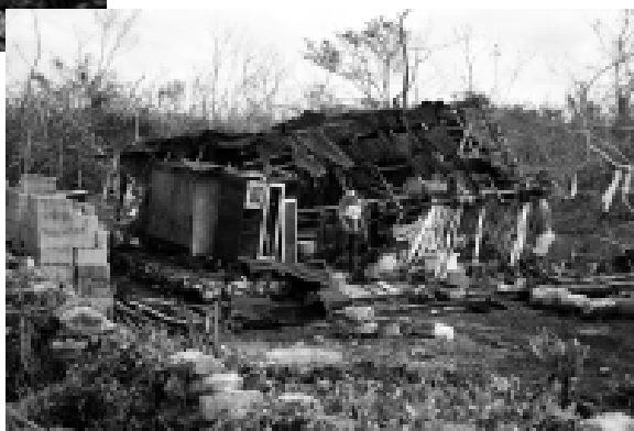
Fig. 48. Dos tipos de vivienda dañadas por el huracán Isidore.
