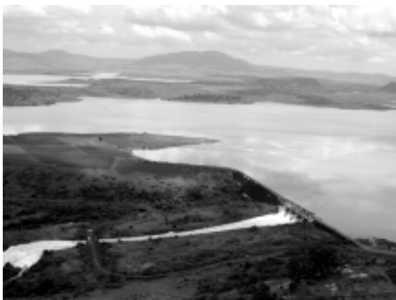
Fig. 37. Presa de almacenamiento.
