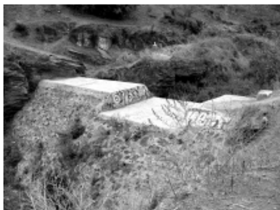
Fig. 38. Presa reguladora de avenidas (rompe-picos).
