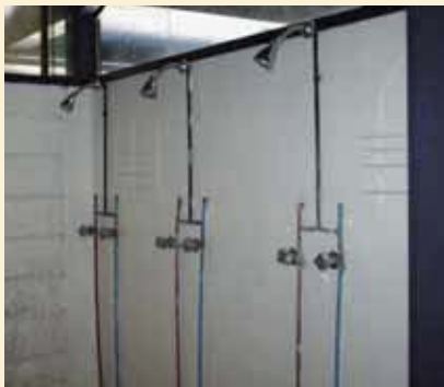
Tubería de cobre pintada en azul y rojo para diferenciar el agua fría del agua caliente, respectivamente.
