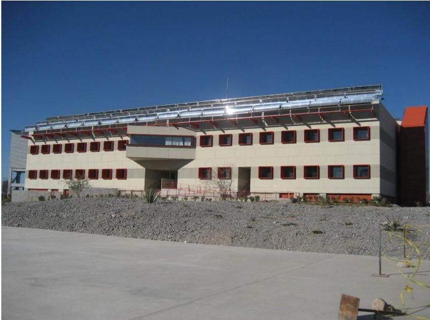
Edificio administrativo de Holcim Apasco en Hermosillo, Son. En la fachada se integran concentradores cilíndrico-parabólicos que generan 290 kWt para aplicaciones térmicas.
