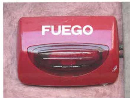
Figura 1.9. Dispositivo de aviso y señalización.
