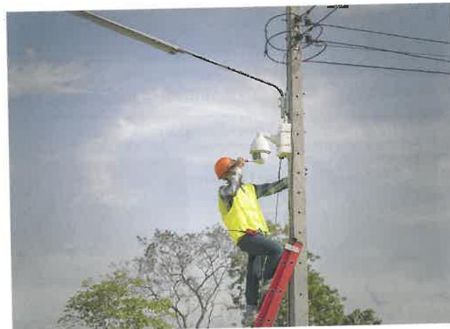
Figura 1.20. Operario realizando tareas de mantenimiento sobre una cámara de CCTV.
