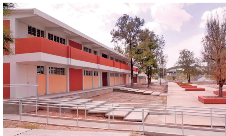
Derivado del Compromiso de Gobierno CG-196, se construyó el Centro de Estudios Tecnológicos en Aguas Continentales ubicado en Irapuato, Guanajuato. Fotos: INIFED.
