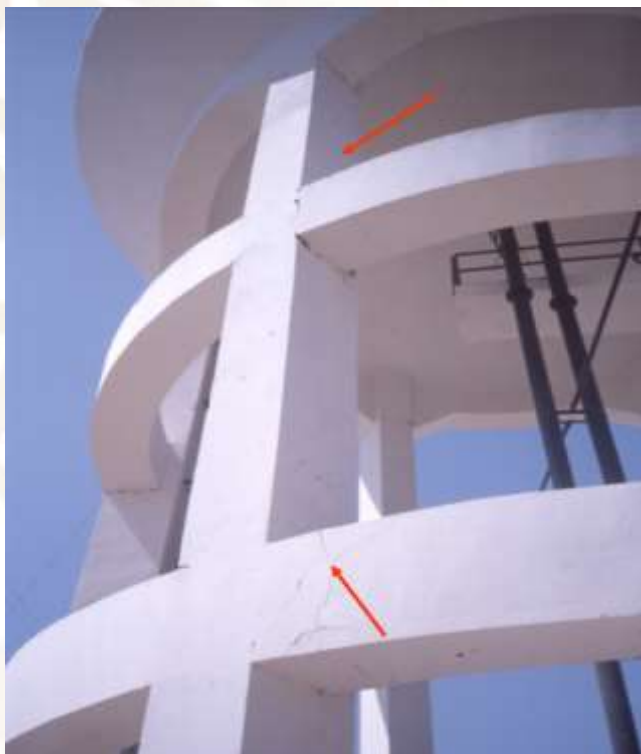
Mecanismo de falla recomendado: daño en vigas y no en columnas.
