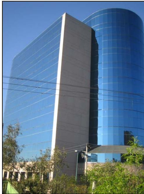
Vista panorámica de fachada izquierda
