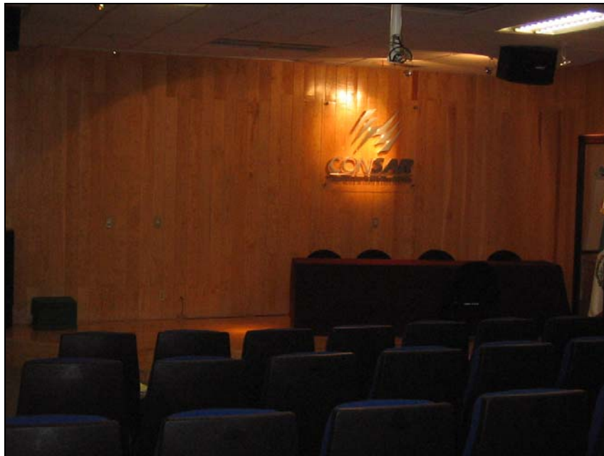
Interior del auditorio, se observan muros de madera en ambas fotos, riesgo de incendio
