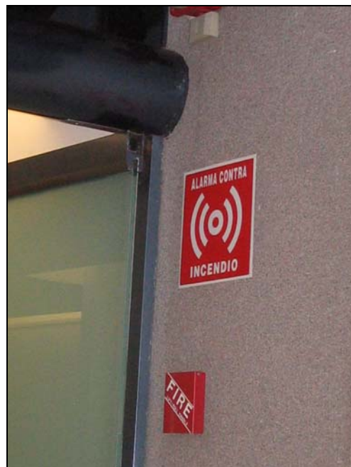
Sensores de humo en entresijos de escaleras y abajo alarma manual contra incendio y estrobos
