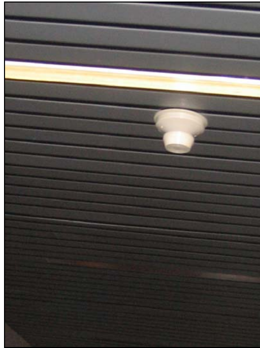
Sensores de humo en entresijos de escaleras y abajo alarma manual contra incendio y estrobos
