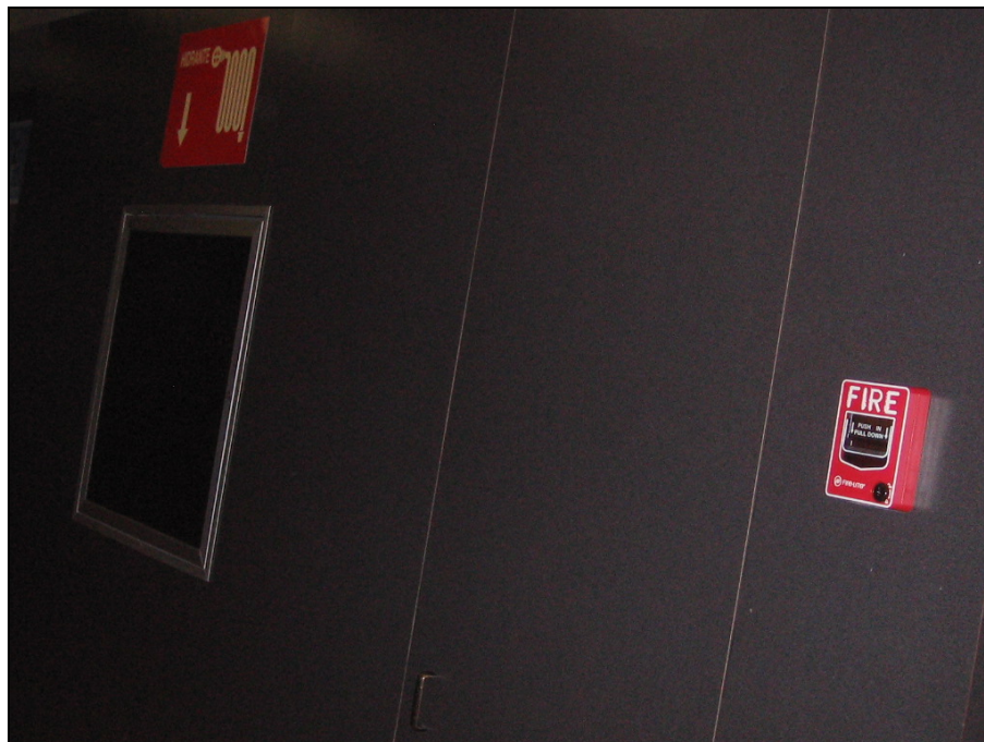
Equipo de Protección Civil interior del edificio en los entrepisos (bomberos), alarma manual contra incendio e hidrantes con señalamientos.
