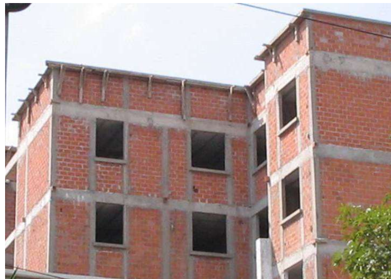
Muros de mampostería confinada
