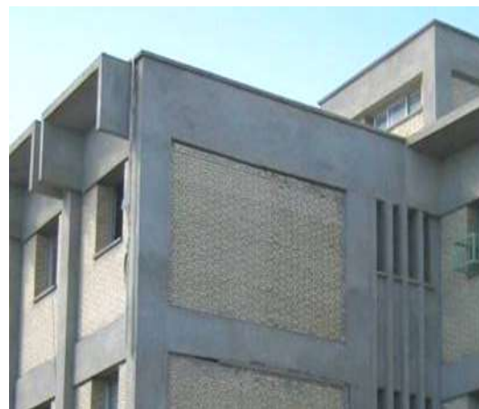
Muros de mampostería confinada
