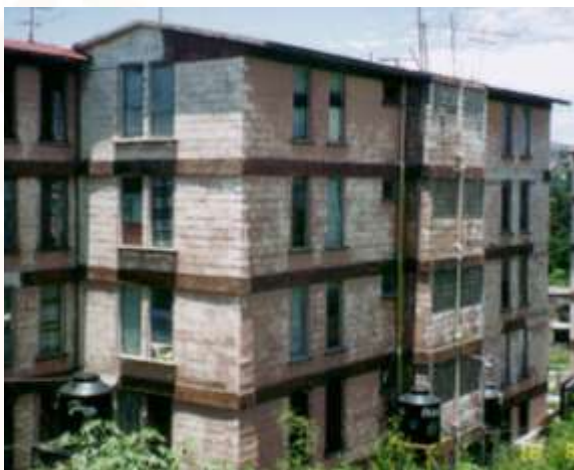
Muros de mampostería con refuerzo interior
