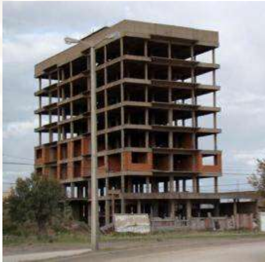
Marcos de concreto
