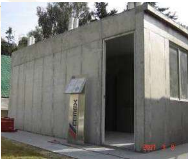
Muros de concreto
