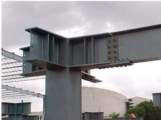
Estructura de acero
