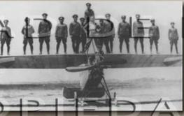
1917. Prueba de resistencia estructural del ala del avión T.N.C.A. Serie "C", utilizada para la instrucción de vuelo y entrenamiento militar.
