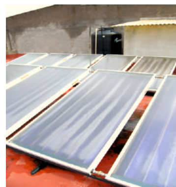
Colectores solares planos colocados
