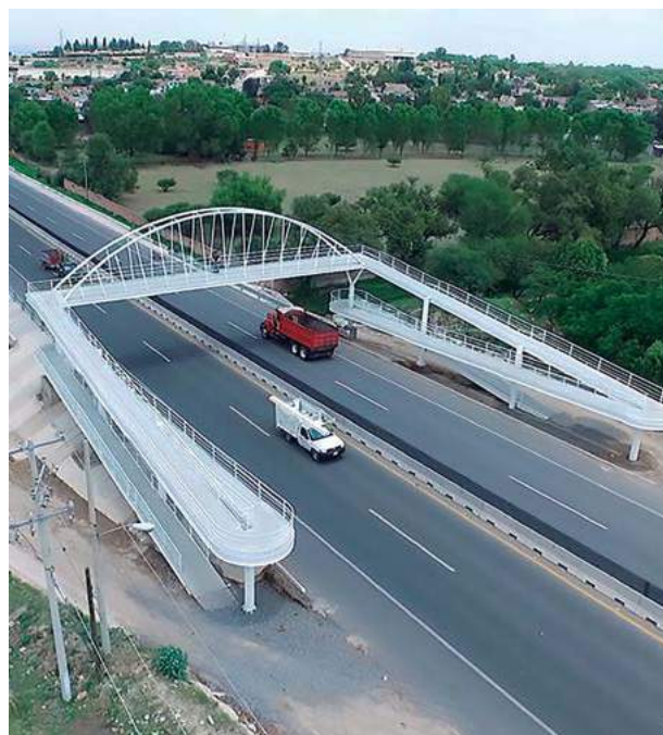
Carretera León - Lagos de Moreno
