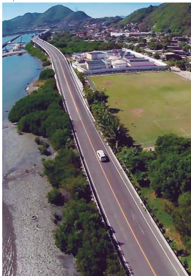
Viaducto de Manzanillo, Colima
