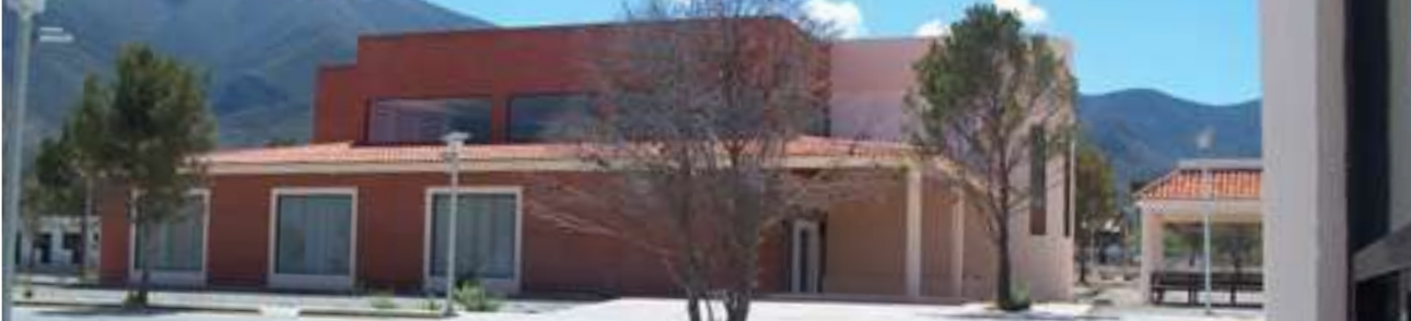
Edificio de cubículos para investigadores
