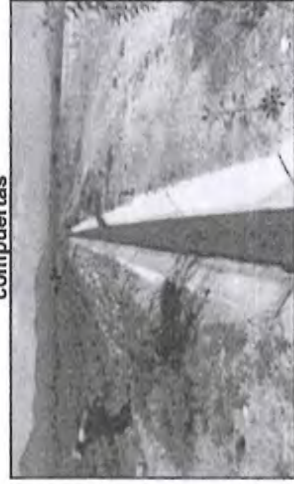
Canal regador revestido de concreto
