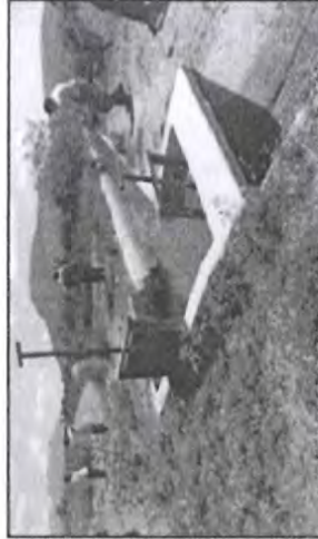
Canal regador revestido de concreto y compuertas
