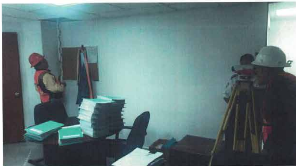
NIVELACIÓN DE PUNTO DE CONTROL Nivelación de punto de control NIVEL 7-E5 bajo losa.
