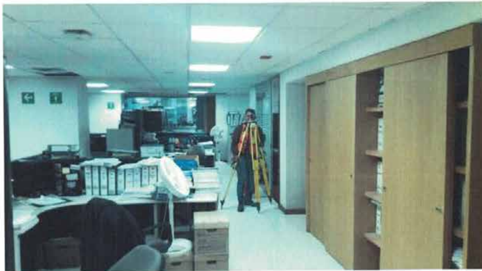
NIVELACIÓN DE PUNTOS DE CONTROL Nivelación de puntos de control en NIVEL 5 con nivel fijo LEICA.
