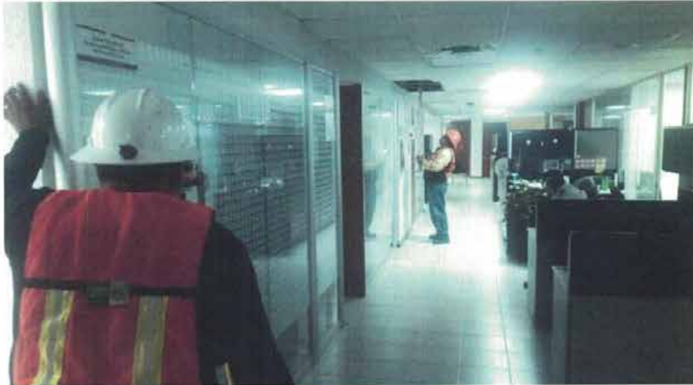
NIVELACIÓN DE PUNTO DE CONTROL Nivelación de punto de control NIVEL 7-D4 bajo losa.
