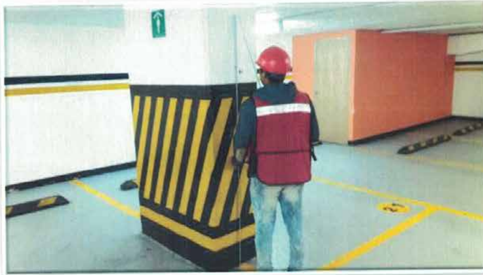
SÓTANO Nivelación de punto de control B2.
