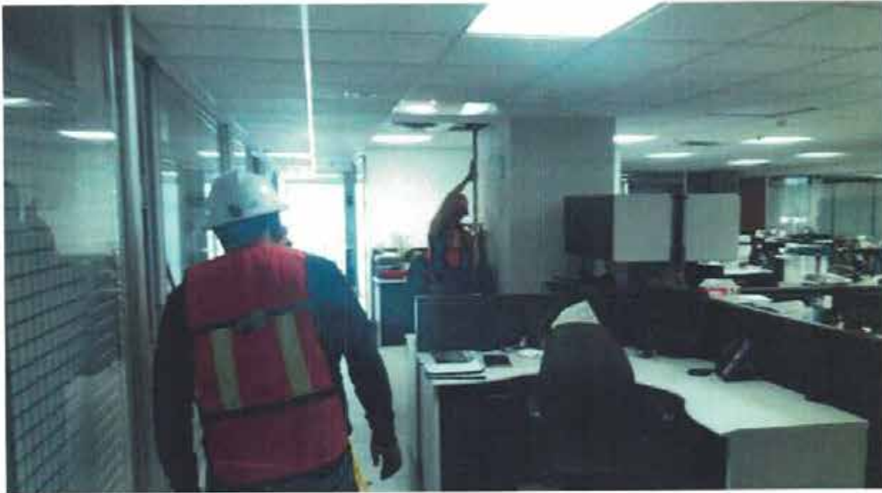
NIVELACIÓN DE PUNTO DE CONTROL Nivelación de punto de control NIVEL 8-D3 sobre losa.
