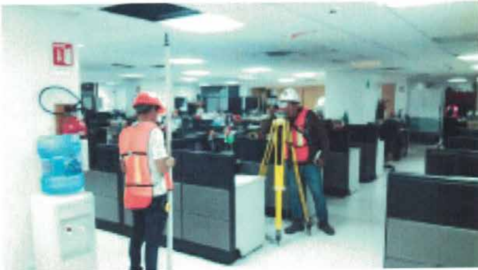
NIVELACIÓN DE PUNTO DE CONTROL Nivelación de punto de control NIVEL 1-E3 sobre piso.
