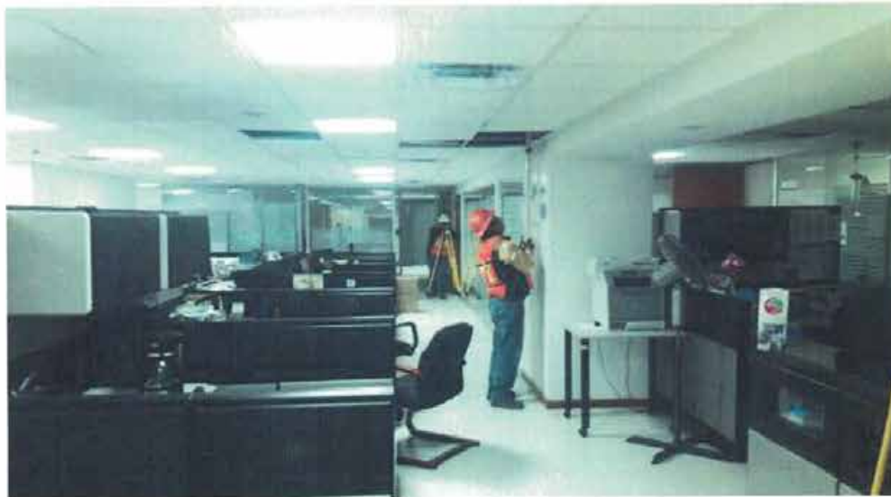
NIVELACIÓN DE PUNTO DE CONTROL Nivelación de punto de control NIVEL 8-D4 bajo losa.
