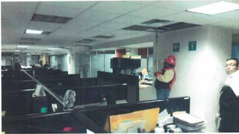
NIVELACIÓN DE PUNTO DE CONTROL Nivelación de punto de control NIVEL 4-C4 bajo losa.
