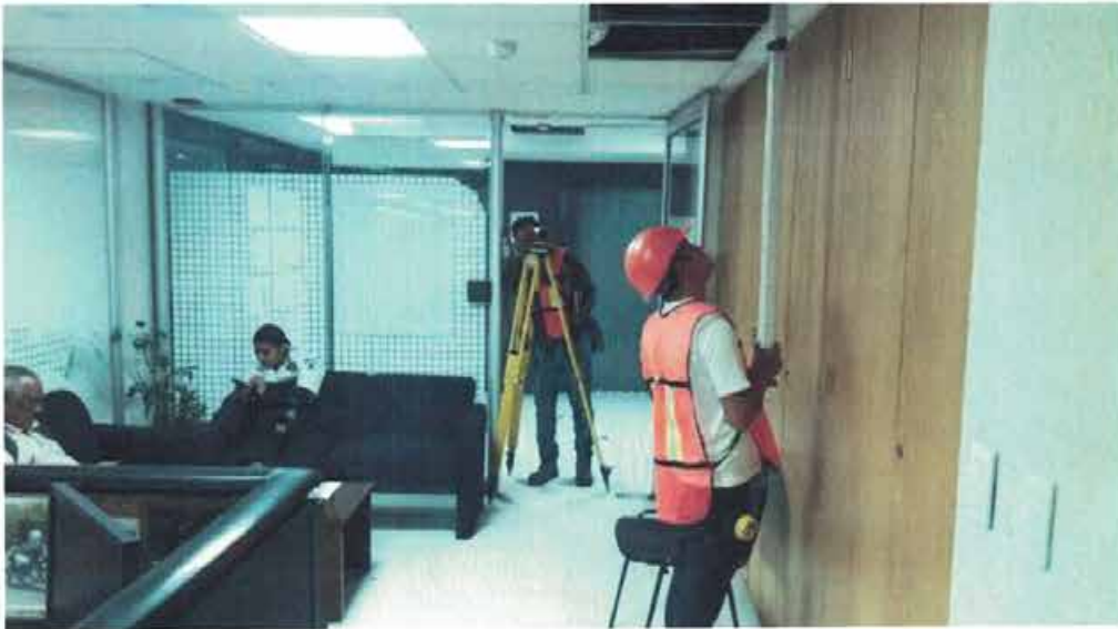
NIVELACIÓN DE PUNTO DE CONTROL Nivelación de punto de control NIVEL 5-E4 bajo losa.
