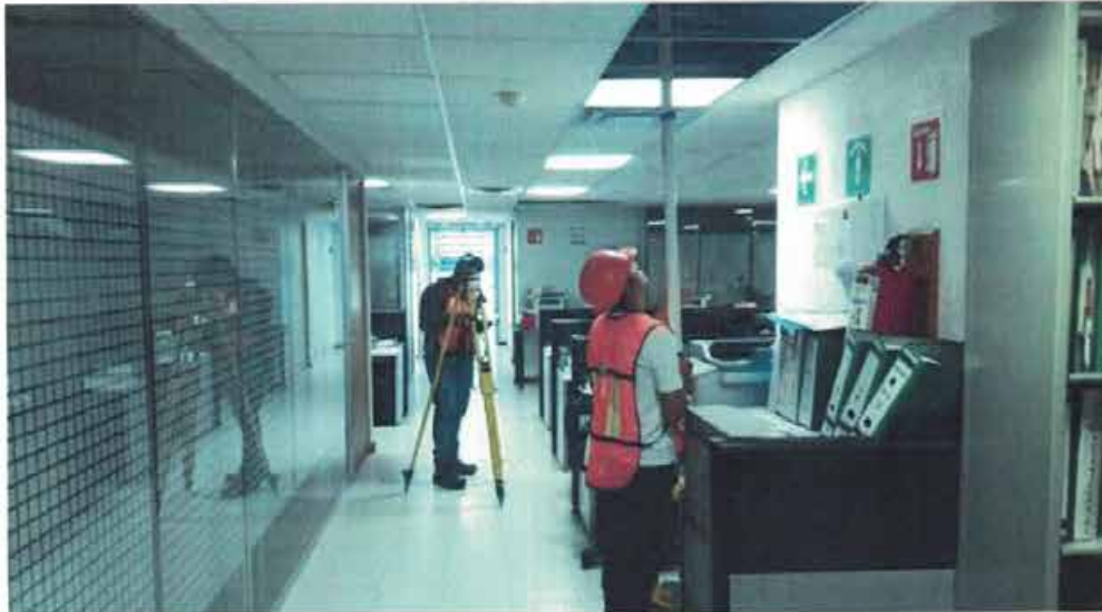
NIVELACIÓN DE PUNTO DE CONTROL Nivelación de punto de control NIVEL 5-D3 bajo losa.
