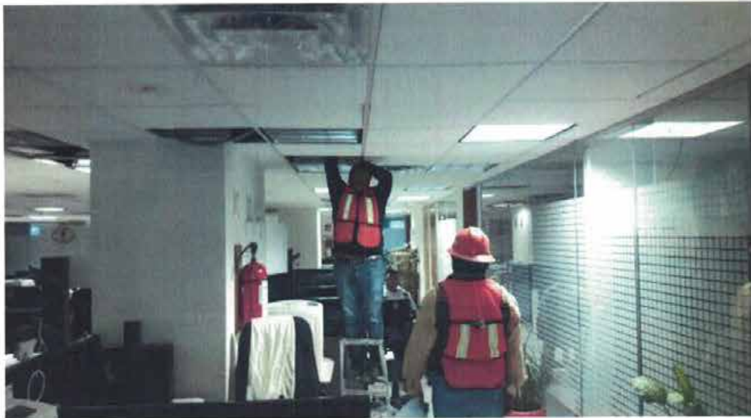
COLOCACIÓN DE PUNTO DE CONTROL Colocación de punto de control NIVEL 4-D3 bajo trabe.
