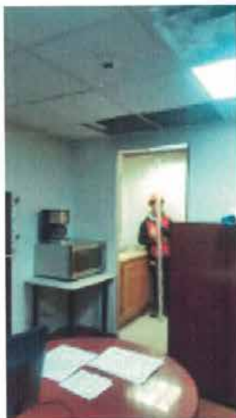
NIVELACIÓN DE PUNTO DE CONTROL Nivelación de punto de control NIVEL 2-D2 sobre piso.
