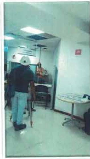
NIVELACIÓN DE PUNTO DE CONTROL Nivelación de punto de control NPB-C5 bajo losa.
