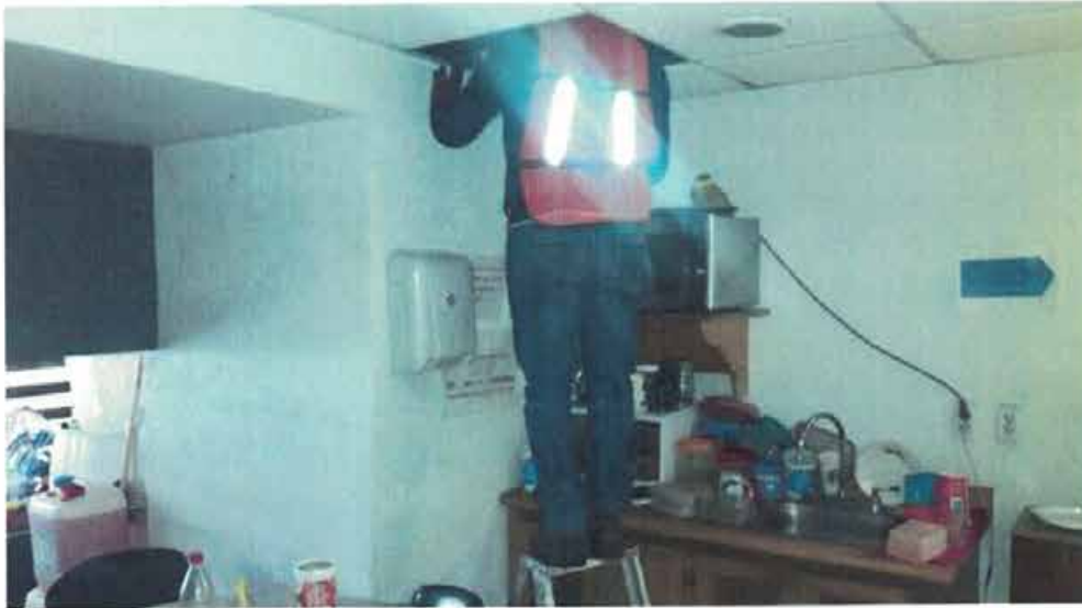
COLOCACIÓN DE PUNTO DE CONTROL Colocación de punto de control NIVEL 4-D2 bajo trabe.
