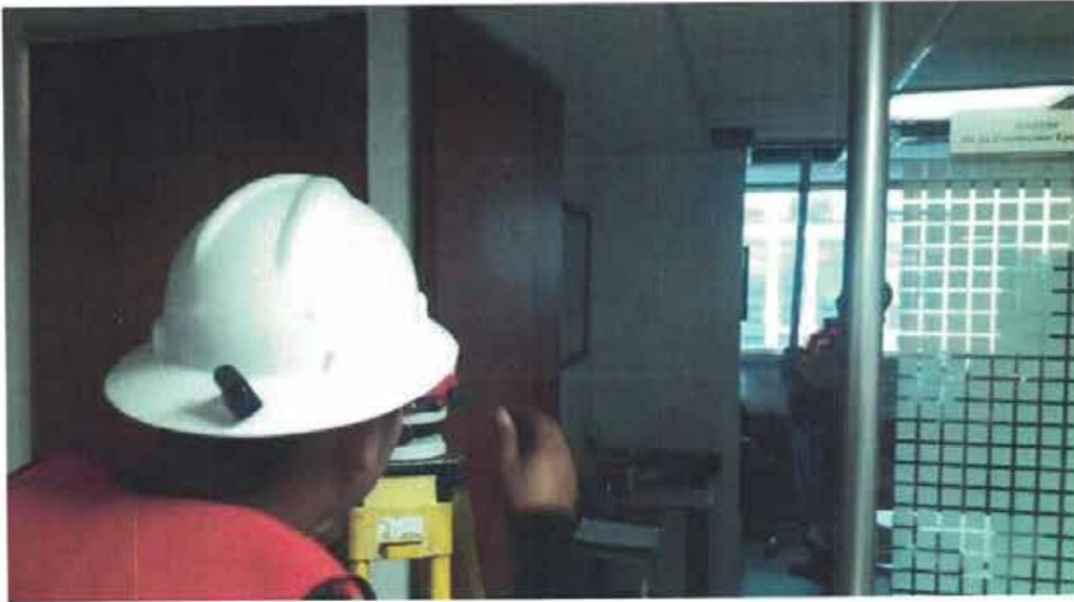
NIVELACIÓN DE PUNTO DE CONTROL Nivelación de punto de control NIVEL 8-C5 bajo losa
