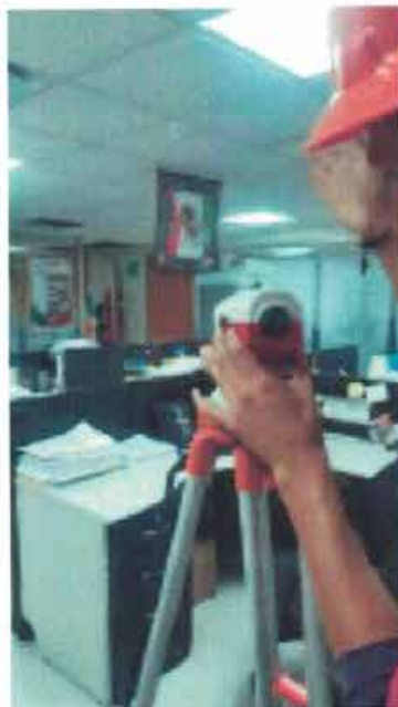
NIVELACION DE PUNTO DE CONTROL Nivelación de punto de control NIVEL 2-E4 sobre piso.
