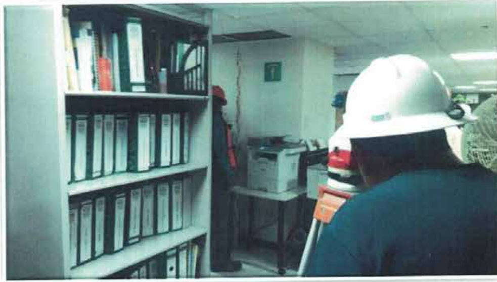
PUNTO DE CONTROL MM-C2 Nivelación de piso en punto de control MMC-2
