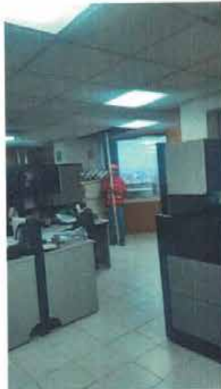
NIVELACIÓN DE PUNTO DE CONTROL Nivelación de punto de control NIVEL 9-B5 bajo losa.
