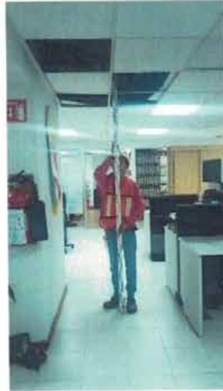
NIVELACIÓN DE PUNTO DE CONTROL Nivelación de punto de control NIVEL 9-C4 bajo losa.
