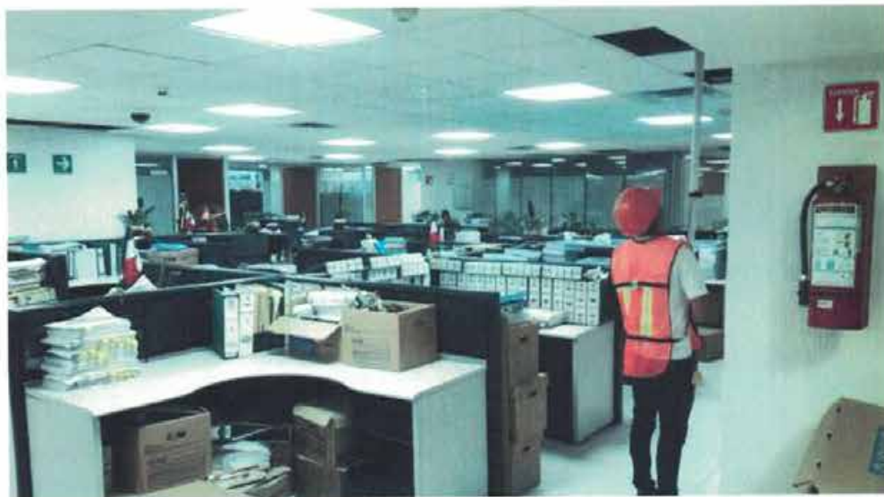
NIVELACIÓN DE PUNTO DE CONTROL Nivelación de punto de control NIVEL 5-D4 bajo losa.
