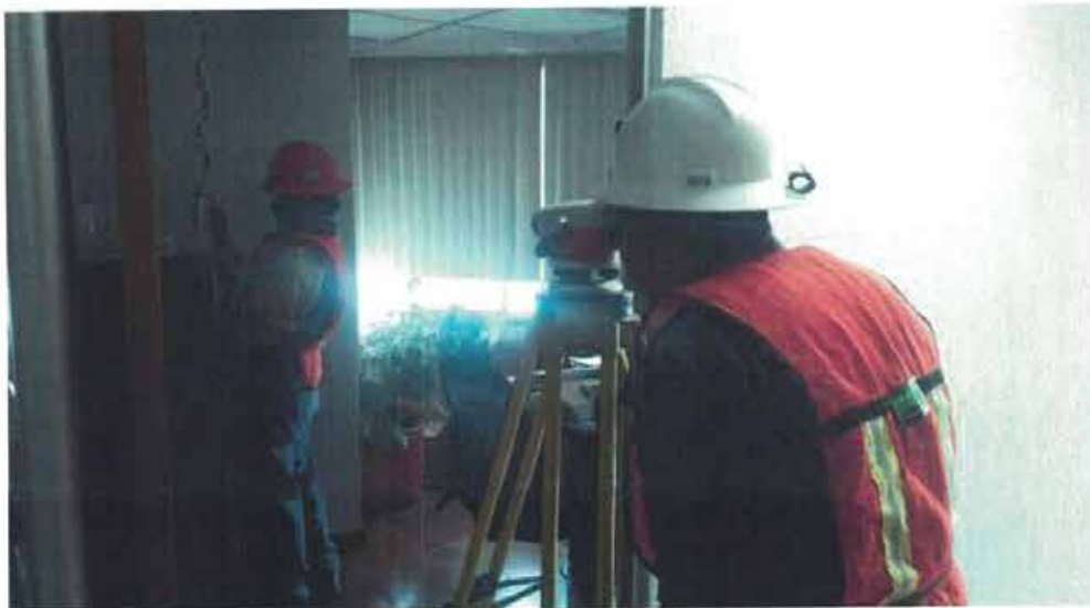
NIVELACIÓN DE PUNTO DE CONTROL Nivelación de punto de control NIVEL 8-E2 bajo losa
