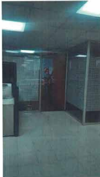
NIVELACIÓN DE PUNTO DE CONTROL Nivelación de punto de control NIVEL 6-E2 bajo losa.
