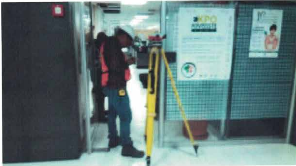
NIVELACIÓN DE PUNTO DE CONTROL Nivelación de punto de control NIVEL 1-E4 bajo losa.
