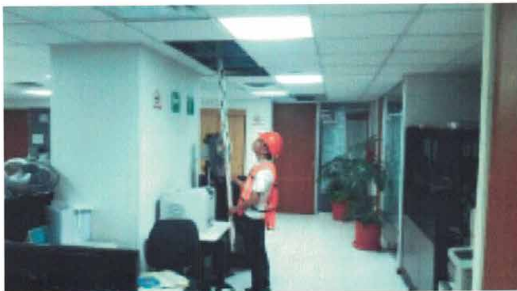
NIVELACIÓN DE PUNTO DE CONTROL Nivelación de punto de control NIVEL 3-C3 bajo losa.
