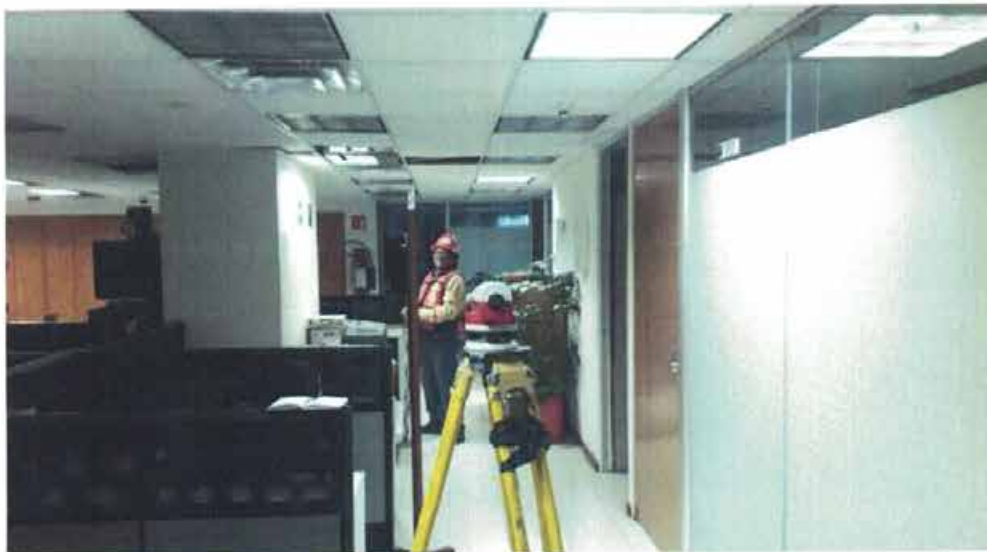
NIVELACIÓN DE PUNTO DE CONTROL Nivelación de punto de control NIVEL 4-C3 sobre piso.
