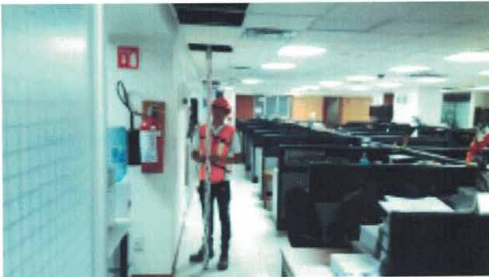
NIVELACIÓN DE PUNTO DE CONTROL Nivelación de punto de control NIVEL 3-D4 sobre piso.
