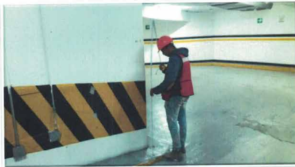
SÓTANO Nivelación de punto de control E2
