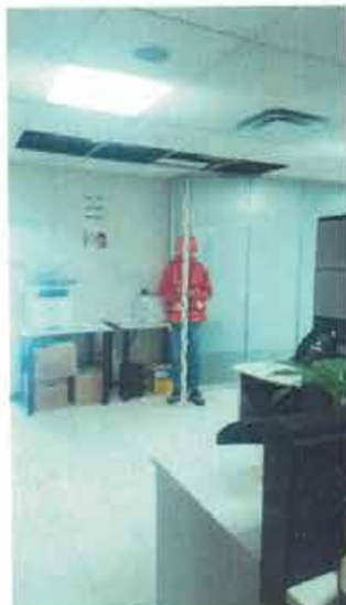
NIVELACIÓN DE PUNTO DE CONTROL Nivelación de punto de control NIVEL 9-E3 sobre piso.
