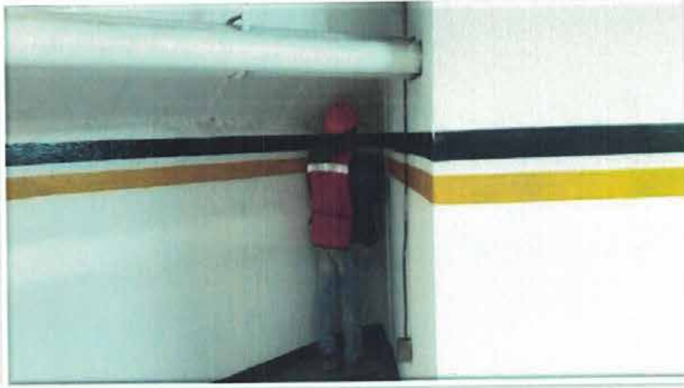
SÓTANO Nivelación de punto de control A4.
