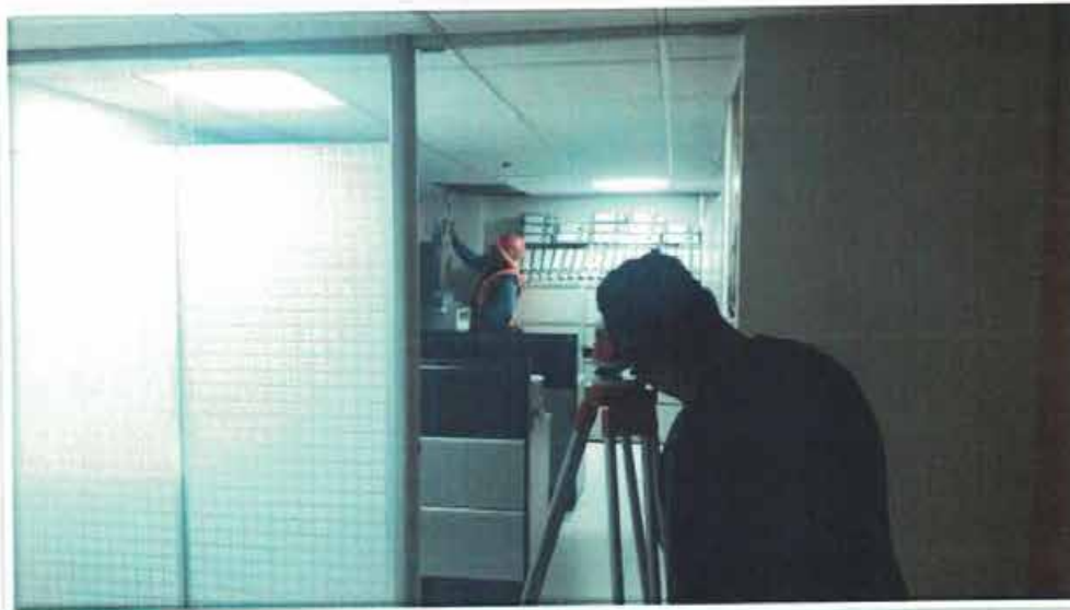
NIVELACIÓN DE PUNTO DE CONTROL NM-F4 Nivelación de punto de control bajo losa dentro de oficina
