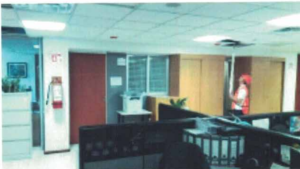
NIVELACIÓN DE PUNTO DE CONTROL Nivelación de punto de control NIVEL 3-C31 bajo losa.
