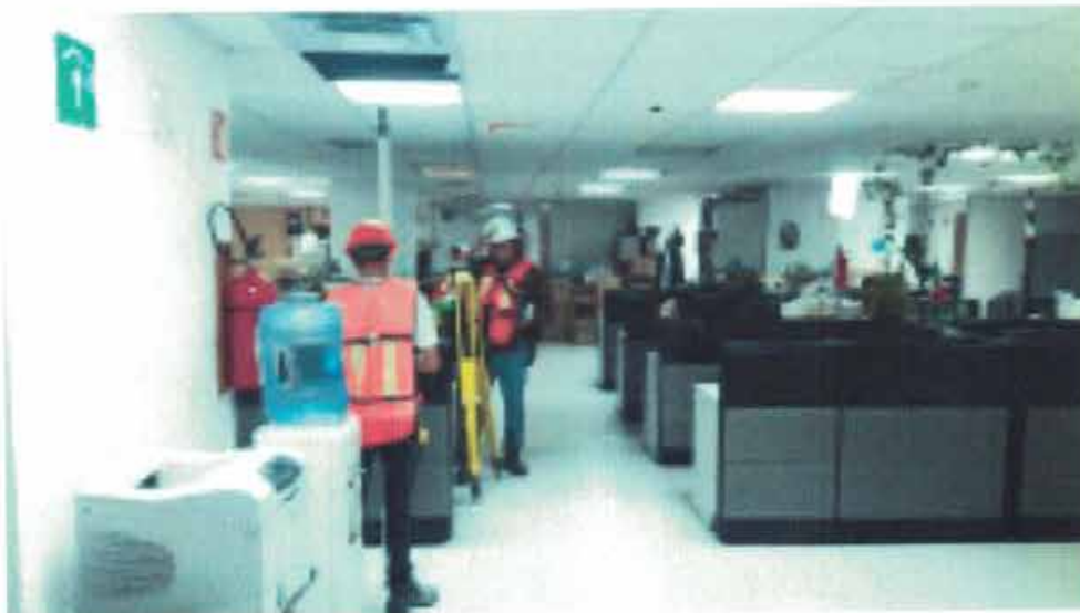
NIVELACIÓN DE PUNTO DE CONTROL Nivelación de punto de control NIVEL 1-D3 sobre piso.
