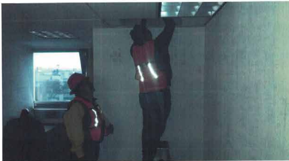
COLOCACIÓN DE PUNTO DE CONTROL Colocación de punto de control NIVEL 4-C5 bajo trabe.
