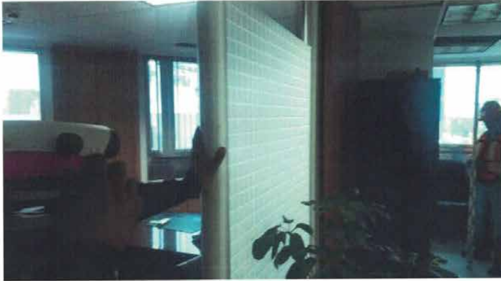
NIVELACIÓN DE PUNTO DE CONTROL Nivelación de punto de control NIVEL 4-B2 sobre piso.
