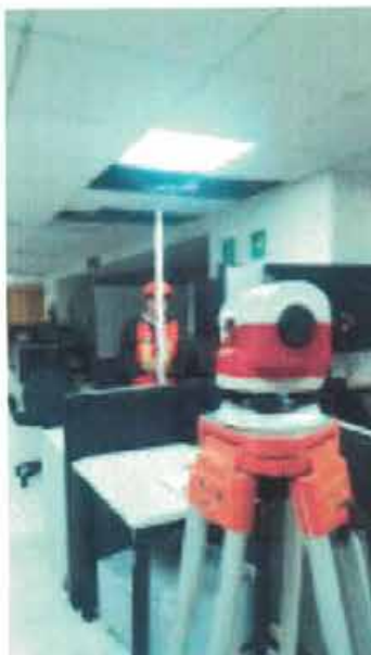
NIVELACIÓN DE PUNTO DE CONTROL Nivelación de punto de control NIVEL 2-D3 sobre piso.
