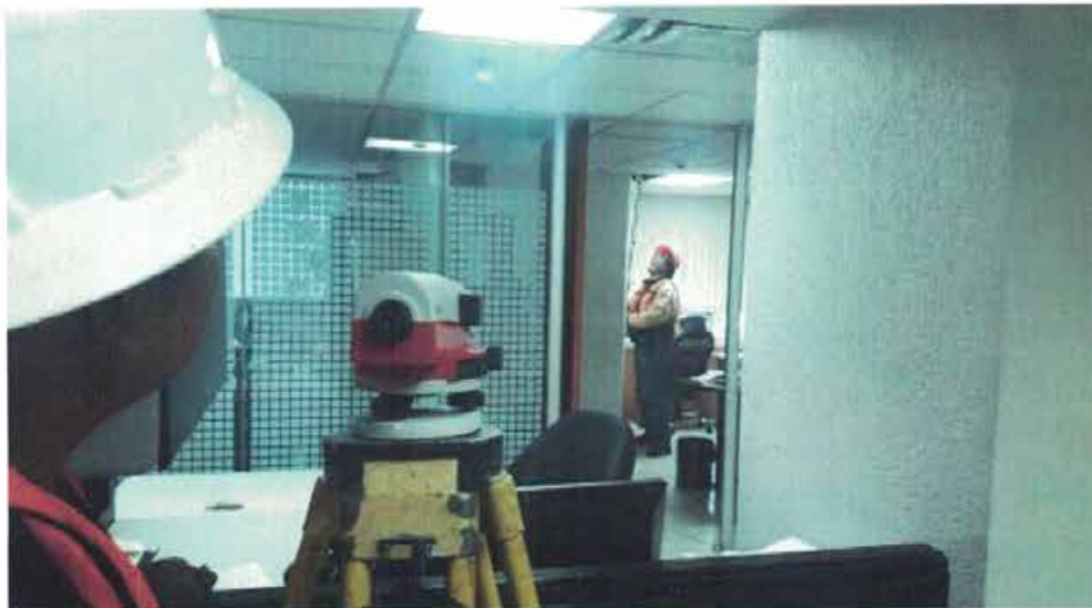
NIVELACIÓN DE PUNTO DE CONTROL Nivelación de punto de control NIVEL 7-C5 bajo losa.
