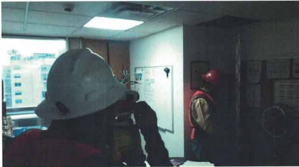
NIVELACIÓN DE PUNTO DE CONTROL Nivelación de punto de control NIVEL 8-E5 sobre piso.
