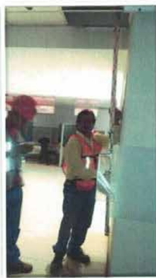
NIVELACIÓN DE PUNTO DE CONTROL Nivelación de punto de control NPB-C4 bajo losa.
