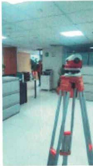
NIVELACIÓN DE PUNTO DE CONTROL Nivelación de punto de control NIVEL 2-E3 bajo losa.
