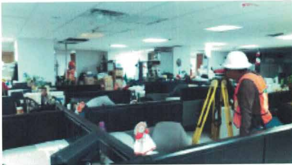
NIVELACIÓN DE PUNTO DE CONTROL Nivelación de punto de control NIVEL 1-C3 bajo losa.
