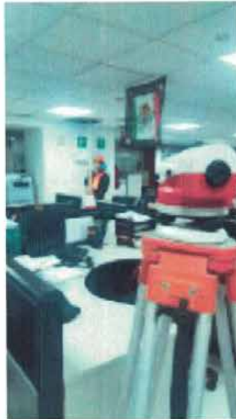
NIVELACIÓN DE PUNTO DE CONTROL Nivelación de punto de control NIVEL 2-D4 bajo losa.
