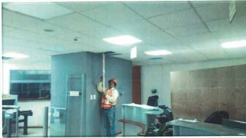
NIVELACIÓN DE PUNTO DE CONTROL Nivelación de punto de control NPB-E4 bajo losa.
