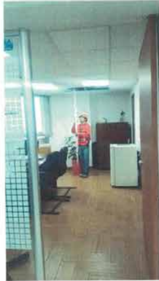
NIVELACIÓN DE PUNTO DE CONTROL Nivelación de punto de control NIVEL 9-A4 bajo losa.
