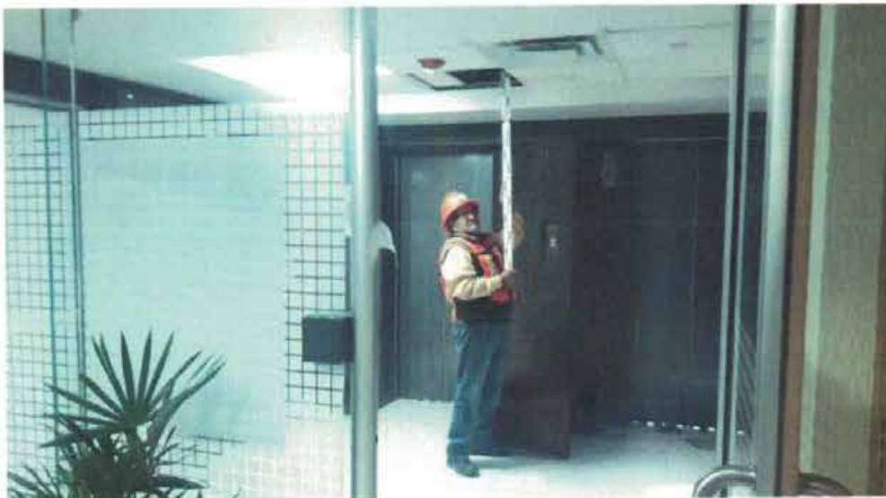
NIVELACIÓN DE PUNTO DE CONTROL Nivelación de punto de control NIVEL 7-Elevador bajo losa
