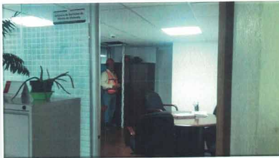
NIVELACIÓN DE PUNTO DE CONTROL NM-A4 Nivelación de punto de control sobre piso terminado dentro de oficina.
