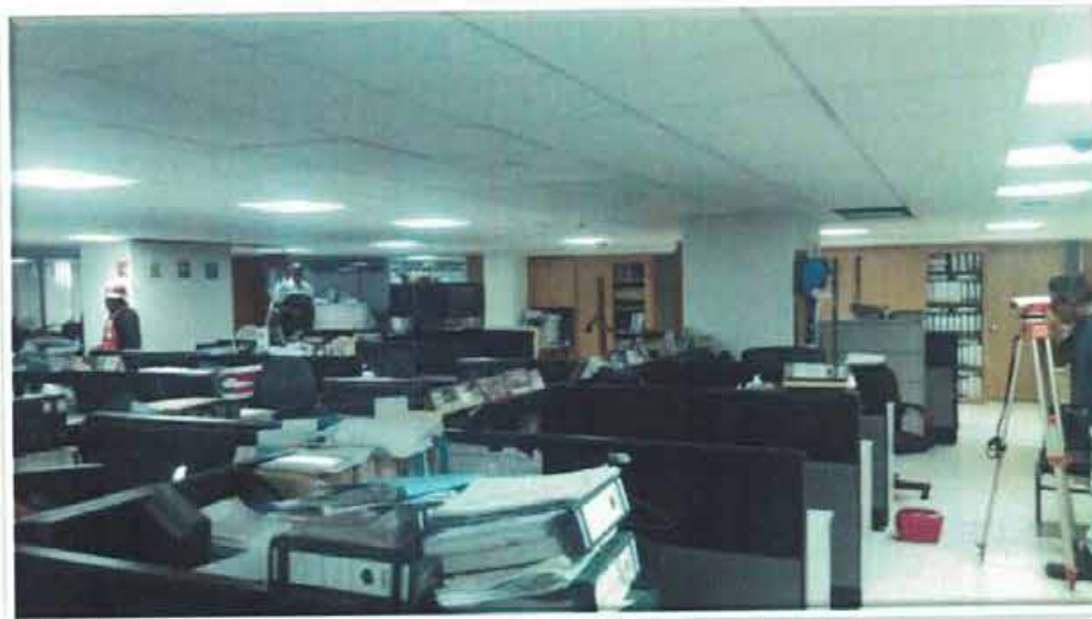
NIVELACIÓN DE PUNTOS DE CONTROL Nivelación de puntos de control con nivel fijo LEICA.
