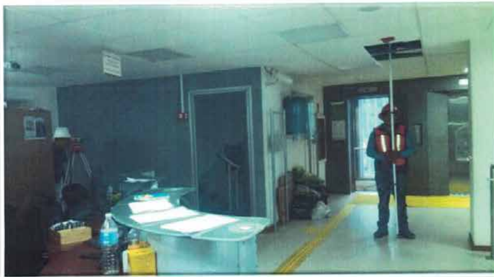
NIVELACIÓN DE PUNTO DE CONTROL Nivelación de punto de control NPB-F4 bajo losa.
