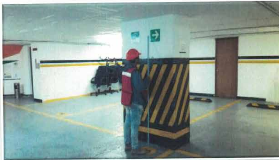
SÓTANO Nivelación de punto de control D5.
