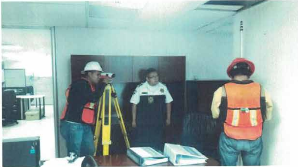
NIVELACIÓN DE PUNTO DE CONTROL Nivelación de punto de control NIVEL 7-B5 sobre piso.
