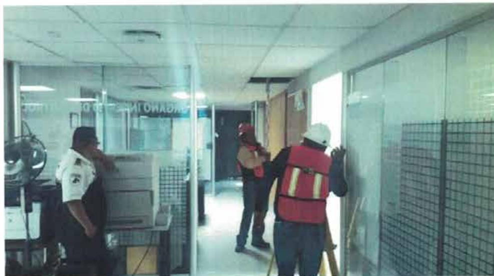
NIVELACIÓN DE PUNTO DE CONTROL Nivelación de punto de control NIVEL 7-E4 bajo losa
