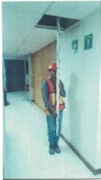
NIVELACIÓN DE PUNTO DE CONTROL Nivelación de punto de control NIVEL 6-F4 bajo losa.
