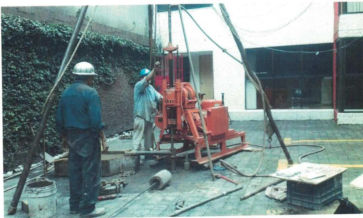
**EJECUCIÓN DE SM-1 DE 15.00 m DE PROFUNDIDAD CON MAQUINARIA ROTARIA LOCALIZADO EN EL PATIO DEL EDIFICIO ANEXO DEL FOVISSSTE.**
