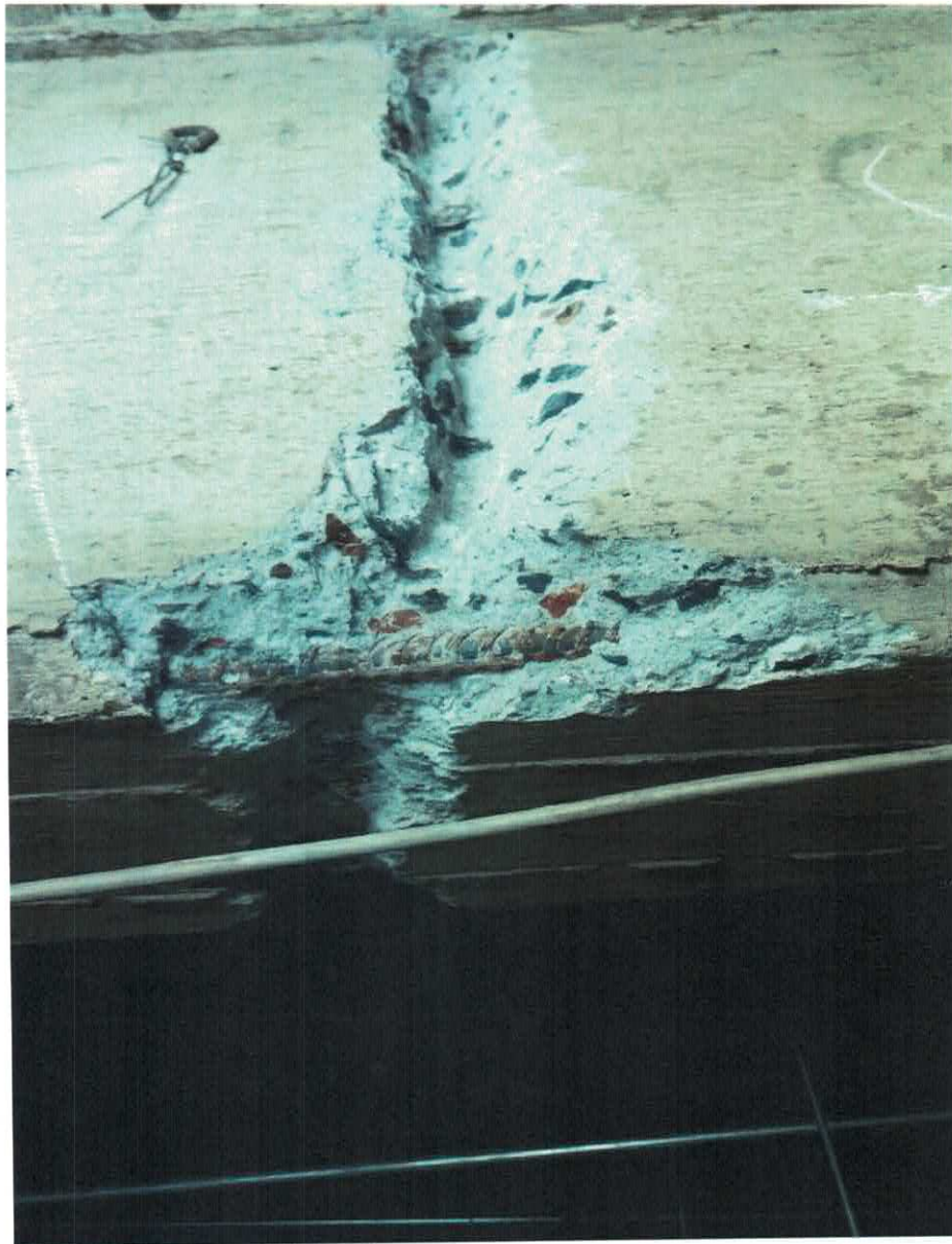
CALA No. 12, REALIZADA EN TRABE DE 25 cm. DE ANCHO POR 60 cm. DE PERALTE, DONDE SE OBSERVA EL ACERO DE REFUERZO LOCALIZADA EN EL NIVEL 9, SOBRE EL EJE (3') ENTRE LOS EJES (C-D).
