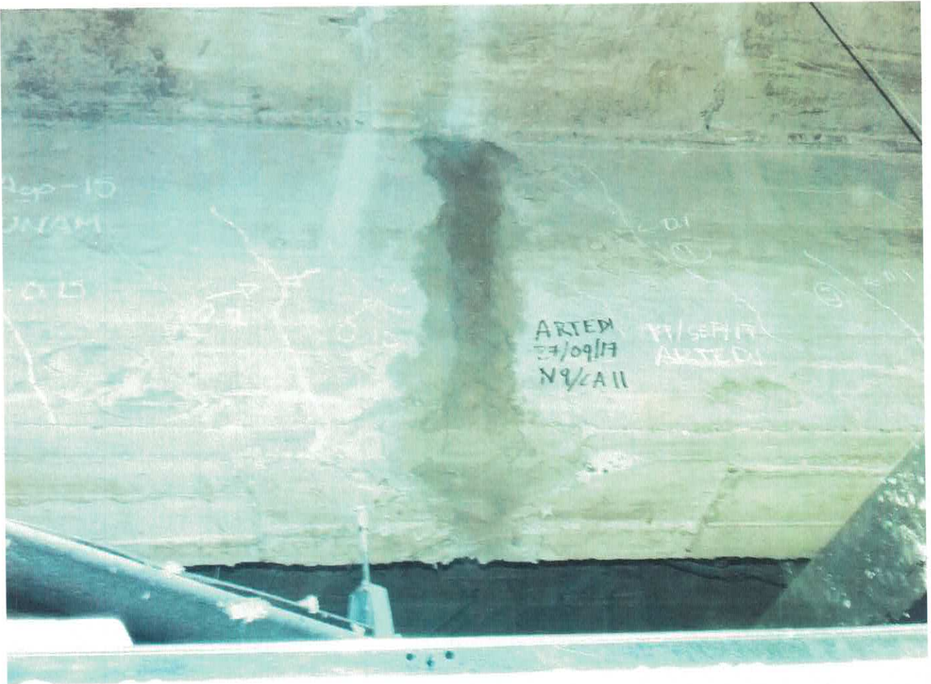
CALA No. 11, REALIZADA EN TRABE DE 25 cm. DE ANCHO POR 60 cm. DE PERALTE, DONDE SE OBSERVA LA CALA REPARADA CON MORTERO CEMENTO-ARENA Y ESTABILIZADOR DE VOLUMEN, LOCALIZADA EN NIVEL 9 SOBRE EL EJE (D) ENTRE LOS EJES (3-4)
