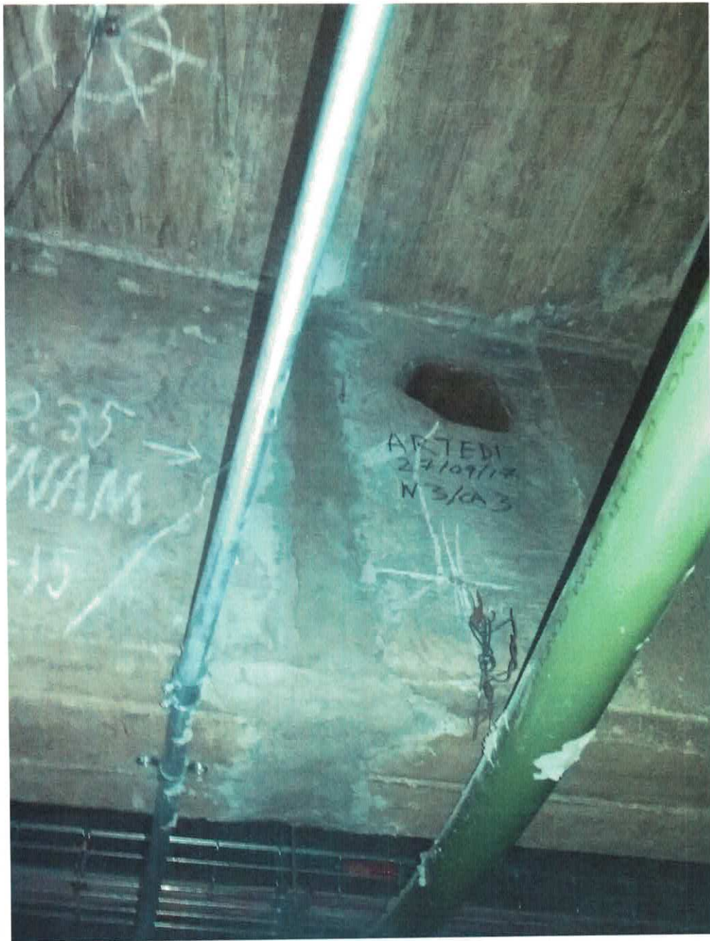
CALA No. 3, REALIZADA EN TRABE DE 25 cm. DE ANCHO POR 60 cm. DE PERALTE, DONDE SE OBSERVA LA CALA REPARADA CON MORTERO CEMENTO-ARENA Y ESTABILIZADOR DE VOLUMEN, LOCALIZADA EN NIVEL 3 SOBRE EL EJE (E) ENTRE LOS EJES (3-4)
